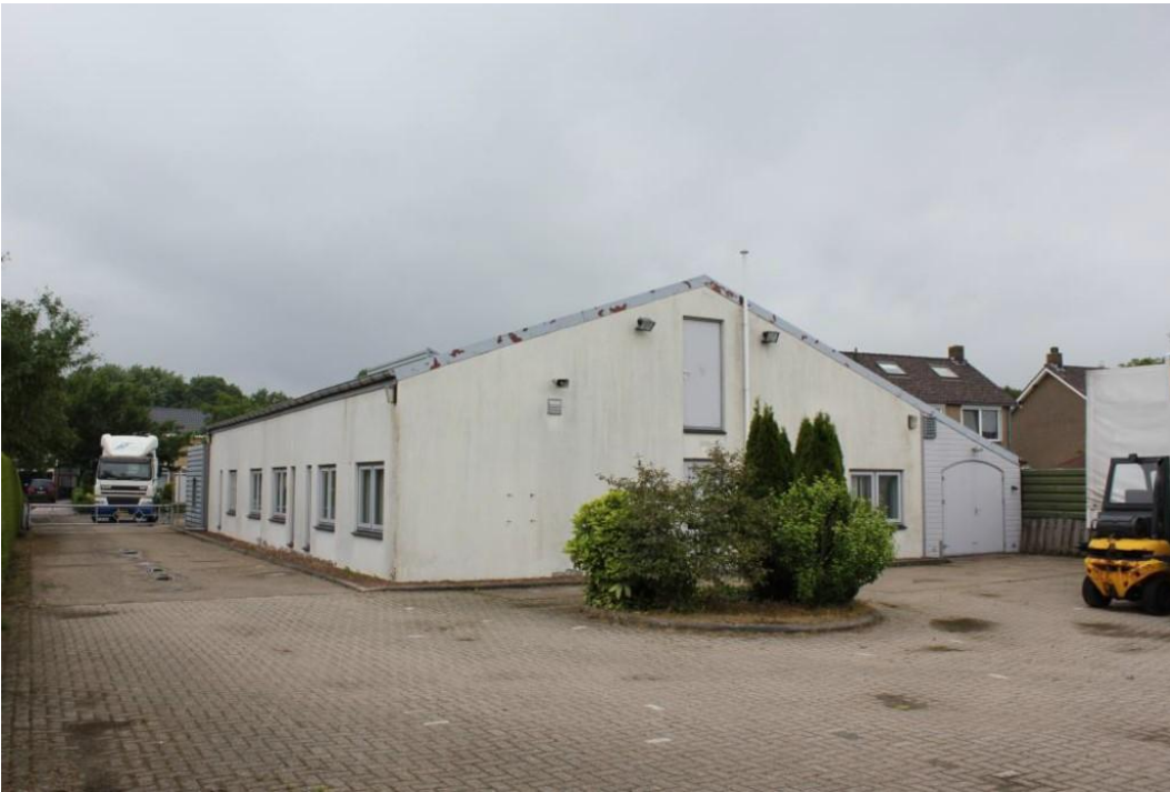
Achterzijde bestaande bedrijfspand met op de voorgrond het volledig verharde achtererf
