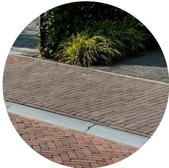
Trottoir in donkerbruine elementenverharding met rws-trottoirband
