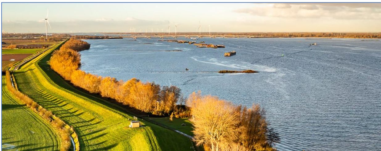
Figuur 2-2 Het dijktraject tussen Moerdijk en Lage Zwaluwe langs het Hollands Diep
