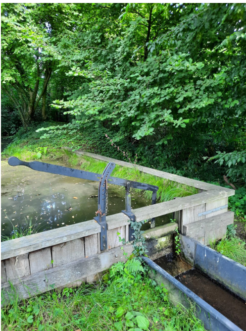
Foto 1: regelwerk in houten damwand
