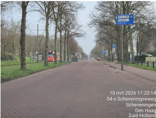
Figuur 17: Scheveningseweg met klinkerverharding
