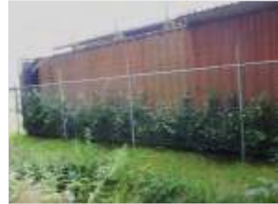
Figuur 4.3 Het clubhuis heeft een metalen damwandprofiel (B).
