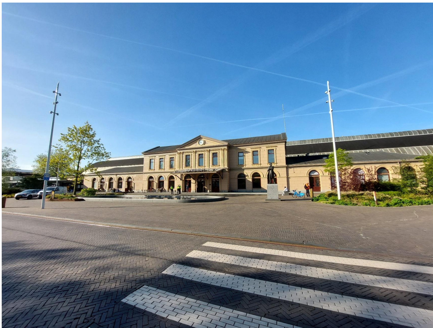
Afbeelding 9. Zicht vanaf het Stationsplein op het stationsgebouw.
