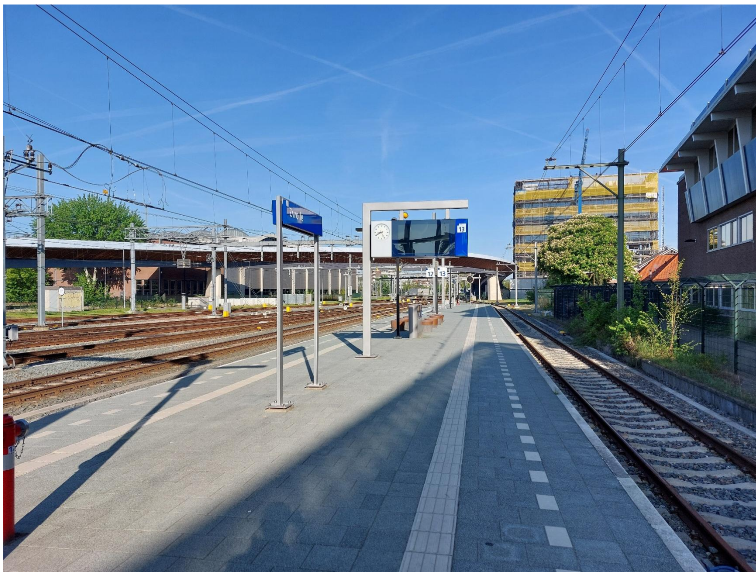
Afbeelding 6. Zicht vanaf het perron op spoor 12 en 13.
