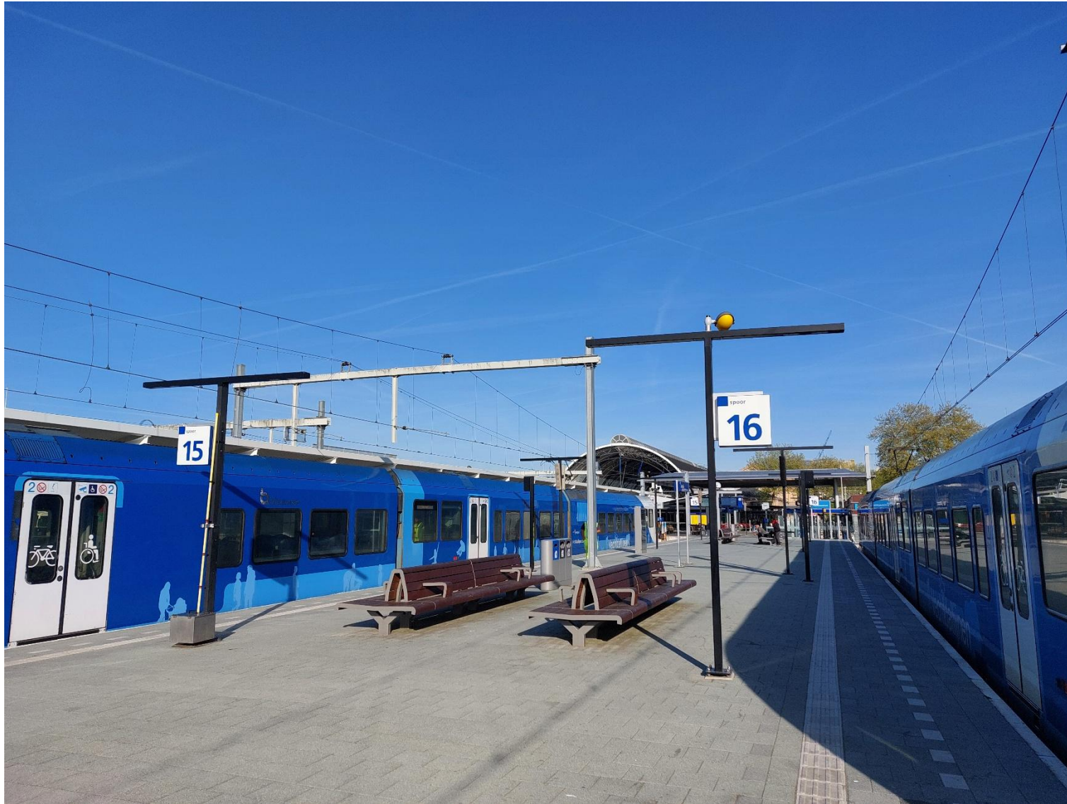
Afbeelding 5. Zicht vanaf het perron op spoor 15 en 16.
