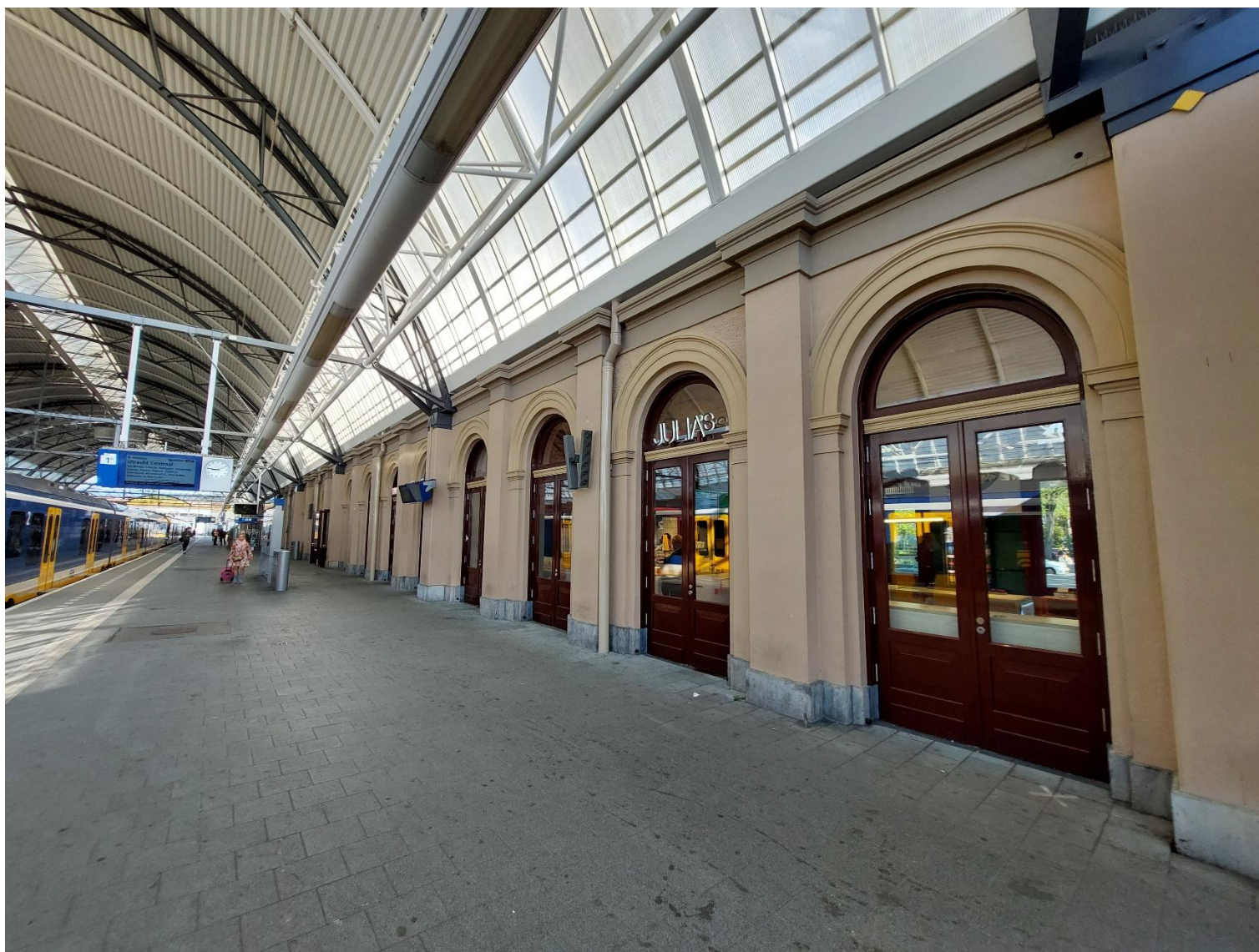
Afbeelding 7. Zicht vanaf het perron op het stationsgebouw met commerciële ruimten.
