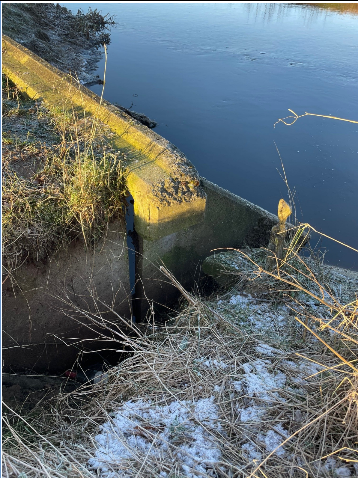
Afbeelding 16: Vershoven uitstroomhoofd / kopbalk ter hoogte van Smakterveld / Afleidingskanaal
