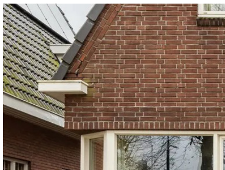
Beperkte gootomloop kopgevel
