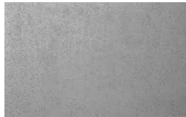
prefab betonnen plint
