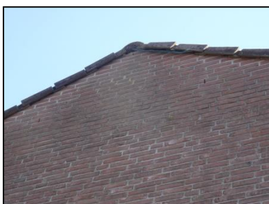
Figuur 4. Vooraanzicht van een woning. De zijgevel heeft open stootvoegen.
