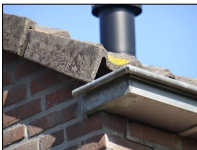
Figuur 16. Zijaanzicht van een woning. Onder de dakpannen is vanuit de dakgoot bereikbare ruimte aanwezig.
