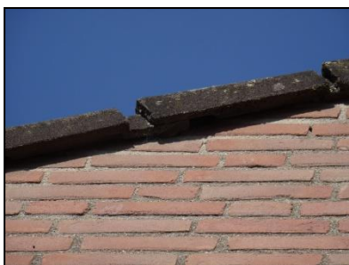
Figuur 19. Vooraanzicht van een woning. Het dak wordt begrensd door overhangende kantpannen met ruimte tot de gevel.
