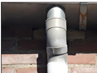
Figuur 10. Detail foto van een woning. Onder de goot, in de gevel is bereikbare ruimte aanwezig.
