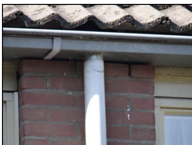
Figuur 7. Vooraanzicht van een woningblok. Onder de dakpannen is bereikbare ruimte aanwezig.
