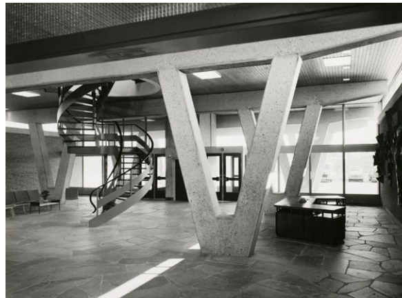
V-vormige kolommen entreegebouw
