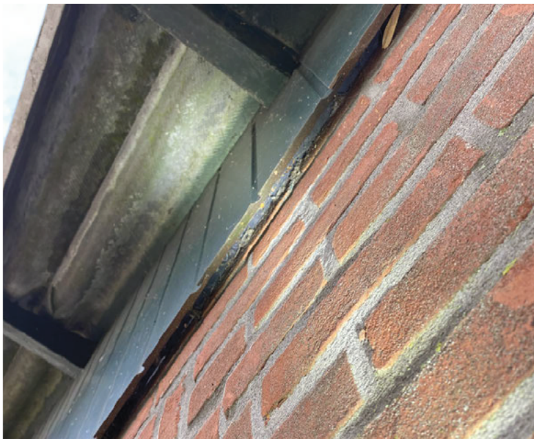
Bijlage 1. Afgedichte gevelbetimmering
