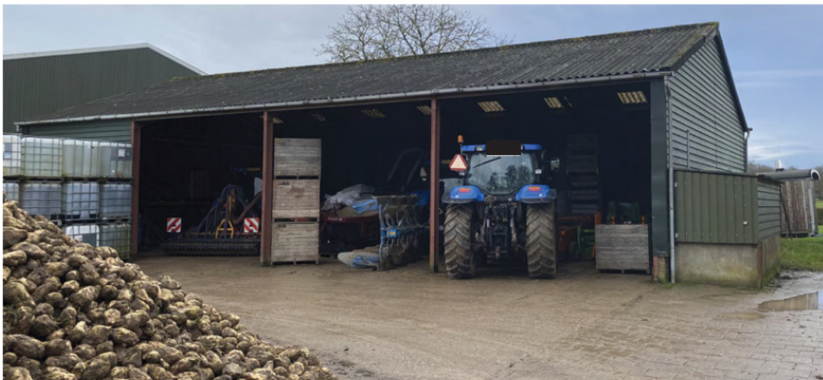
Afbeelding 4. De te slopen kapschuur
