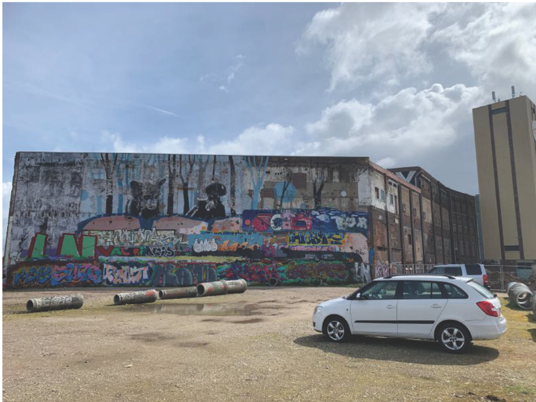
Figuur 10 Blinde westgevel en zuidgevel van Latenstein (fase 2a, april 2023).
