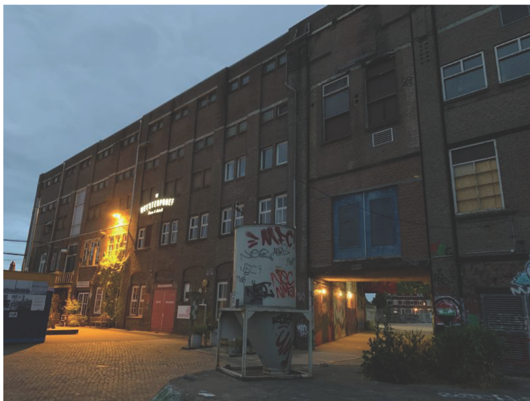
Foto 3 Verlichting aan de noordgevel bij fase 2b en in de onderdoorgang.
