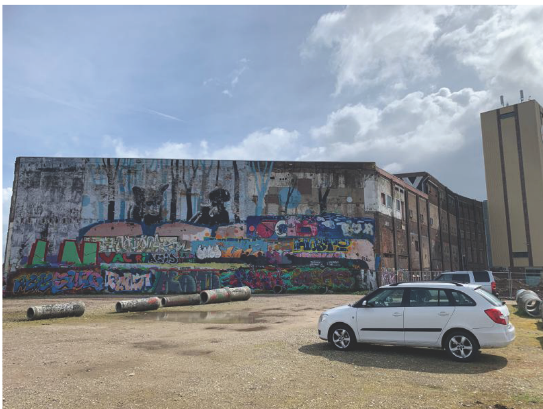
Figuur 18 Blinde westgevel en zuidgevel van Latenstein (fase 2a, april 2023).
