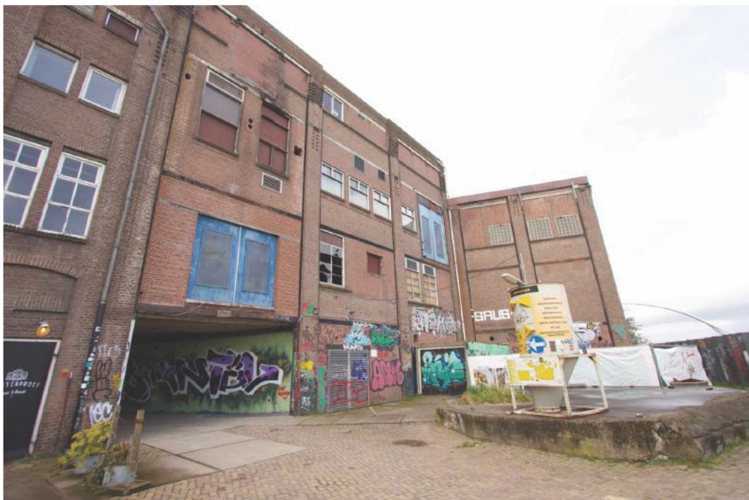
Figuur 20 De oostgevel van Latenstein waar het grenst aan fase 2b (april 2023).
