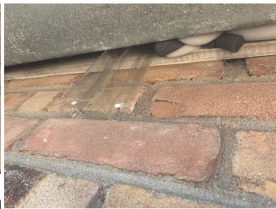
Toepassing onder dakgoot in combinatie met vulschuim (links) en over een open stootvoeg (rechts).
