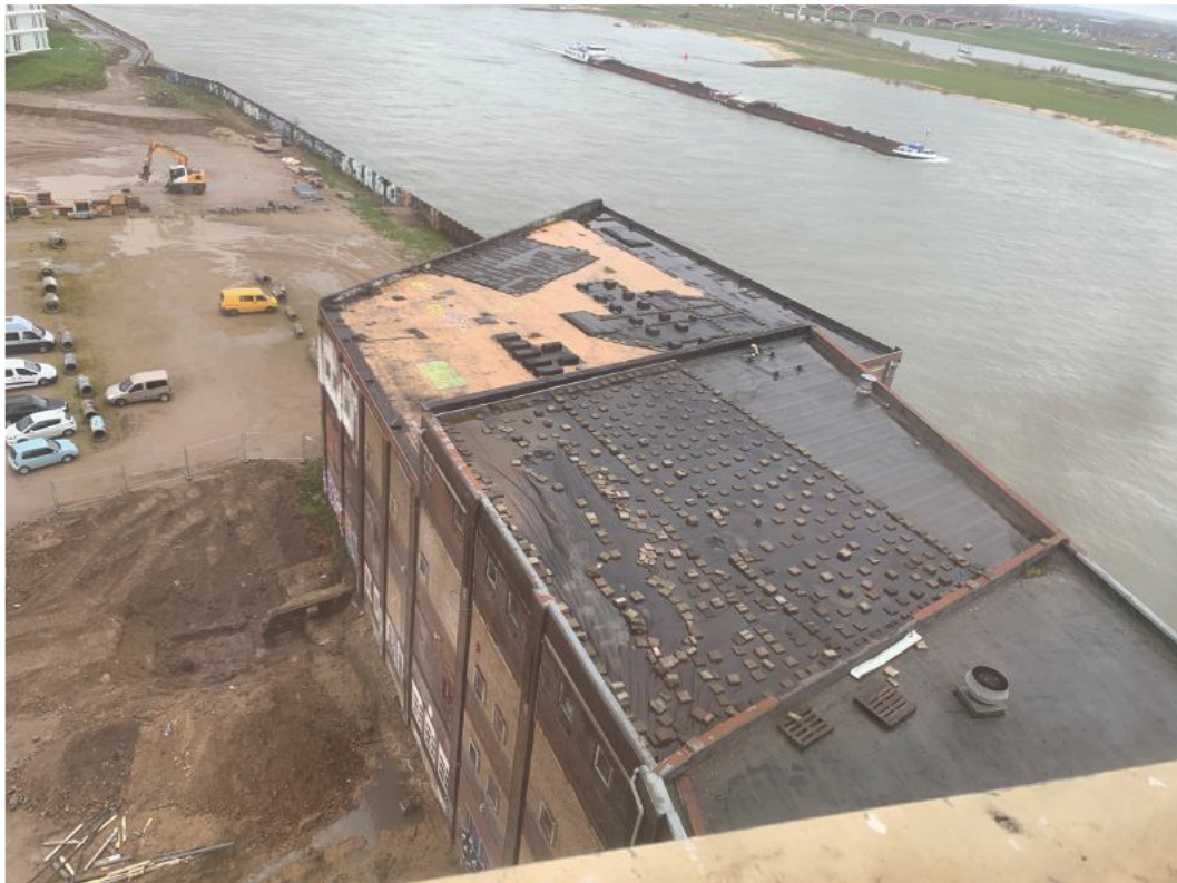
Figuur 21 De platte daken van Latenstein (fase 2a, lichte dak) en Oscar Leeuwgebouw (fase 2b), gezien vanuit de Honig toren. Het dak is ongeschikt voor vogels om op te broeden (april 2023).
