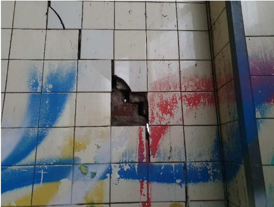
Figuur 6. Deze scheur in de muur aan noordwestzijde biedt eveneens toegang tot het gebouw voor vleermuizen, maar zal door de verder solide muur zelf geen andere functie kunnen hebben als zomer- of paarverblijf. Deze functie is hier uitgesloten door SAB. Ook is hierbij geen andere activiteit vastgesteld.
