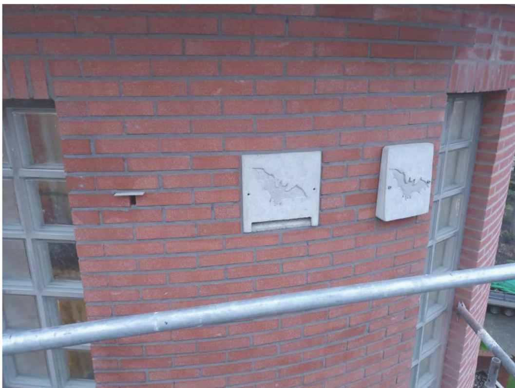
Figuur 23 Een aluminium stripje boven de open stootvoeg voor een betere vindbaarheid.
