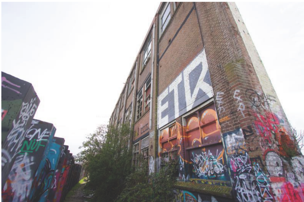
Figuur 11 De noordgevel van het Latenstein gebouw (fase 2a, april 2023).
