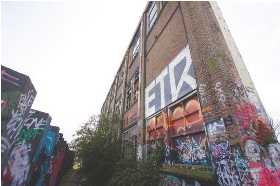
Figuur 19 De noordgevel van het Latenstein gebouw (fase 2a, april 2023).
