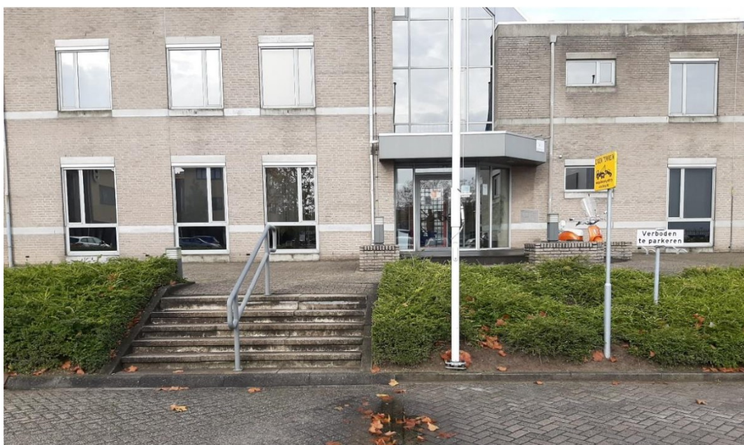
Bestaande toestand (te verwijderen) tweede trap. Het Talud zal hier worden hersteld. De midden leuning wordt hergebruikt bij hoofdentreetrap naar het kantoor.
