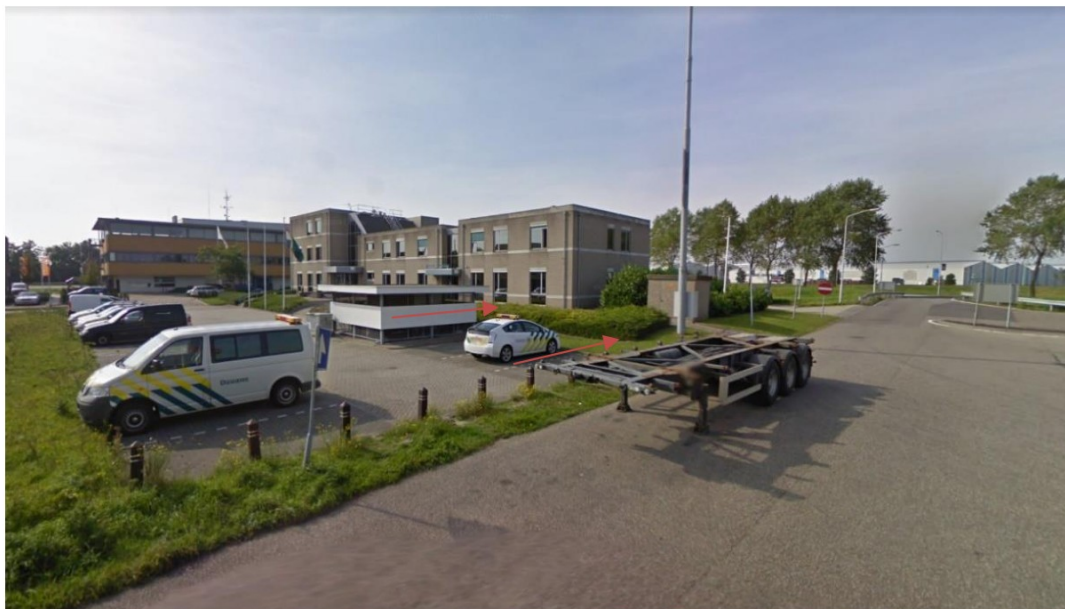
Zicht op de parkeerplaats aan de voorzijde (Oostzijde) van het kantoor. De parkeerplekken en de fietsenstalling zullen iets in het bestaande talud van het terrein worden geschoven.
