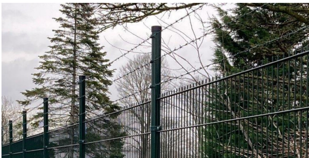
Detail foto voorgesteld 3 strengs prikkeldraad overklimbeveiliging geïntegreerd in de hekopbouw.
