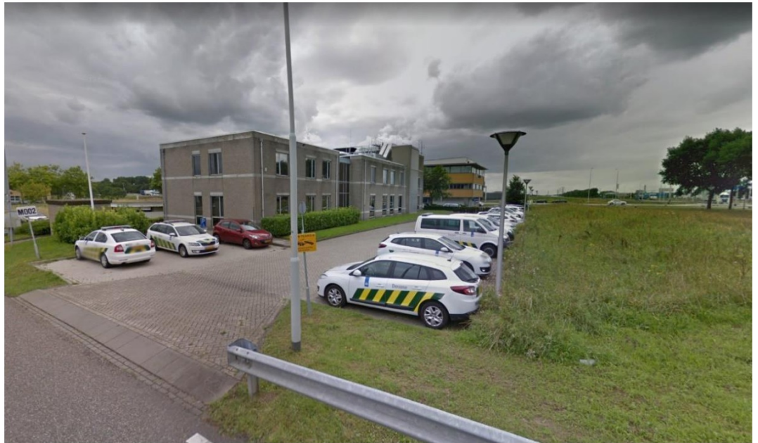
Entree parkeerplaats achterzijde kantoorgebouw, gezien vanaf de Noordzijde van het gebouw.
