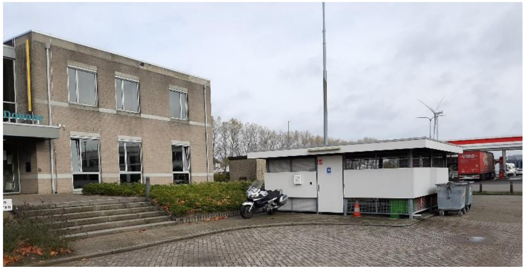
Huidige positie fietsenstalling. De fietsenstalling wordt gedemonteerd en aangepast voor zijn nieuwe positie op het terrein.
