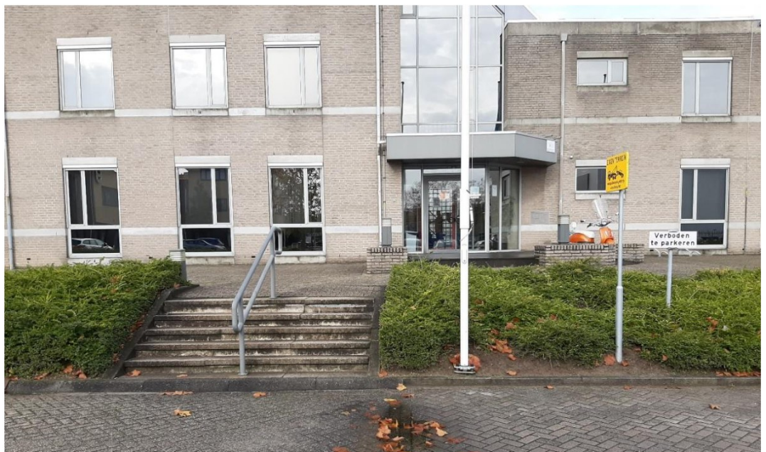
Bestaande toestand (te verwijderen) tweede trap. De midden leuning wordt hergebruikt bij hoofdentreetrap naar het kantoor.
