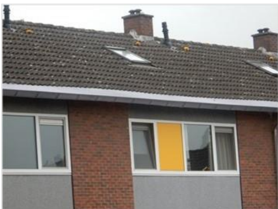
Figuur 8.8 Voorbeeld van een afgeschermd dakgoot van de woning.
