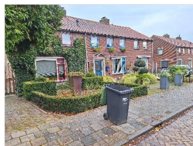
Figuur 1.5. Woning aan de Langeslag 59. Foto genomen richting het noord-oosten.
