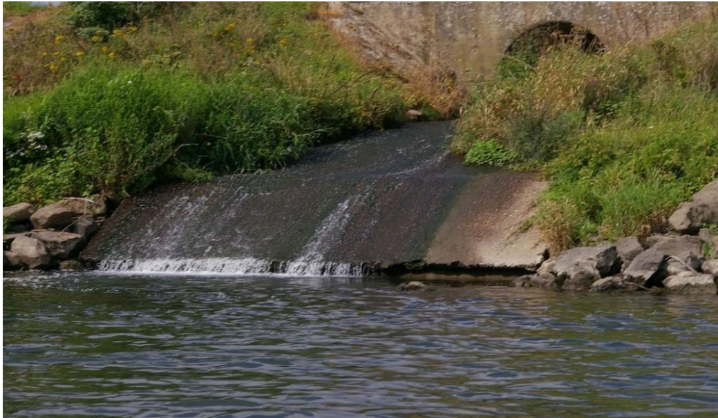
Figuur 4 Te verwijderen betonplaat bij de uitstroming van een beek in de Grensmaas
