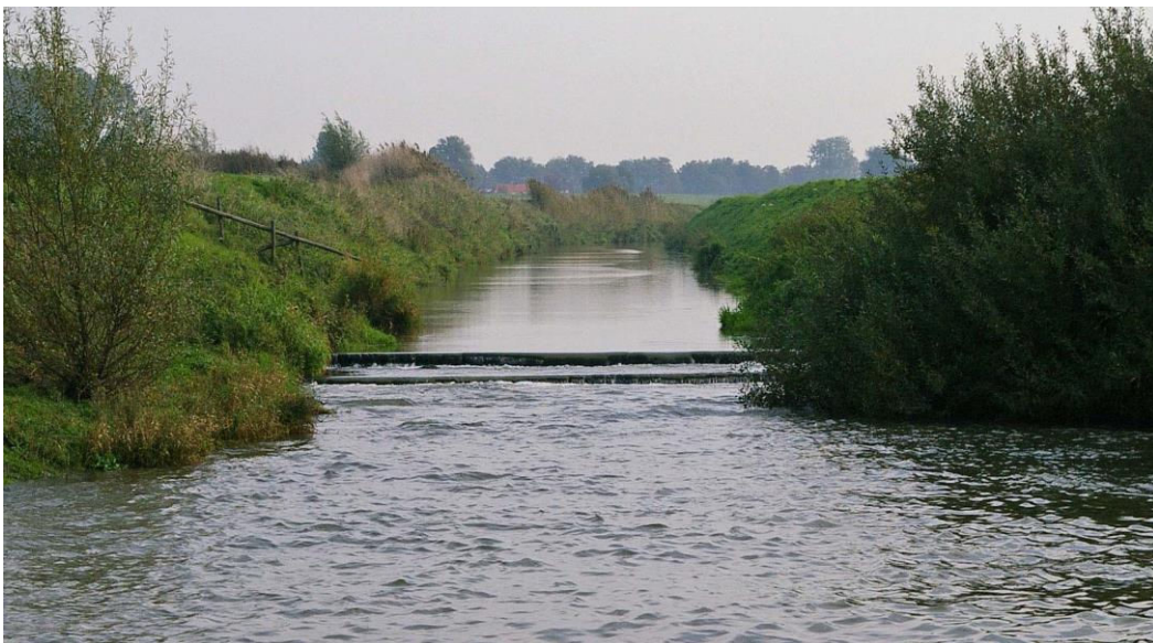
Figuur 5 Op te ruimen stuw in een beekmonding langs de Maas
