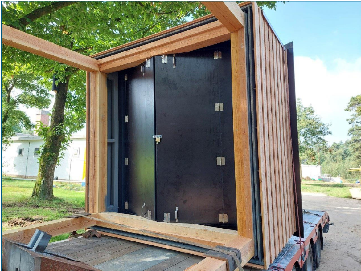
Figuur-7 Onderzijde uilenkast met zichtbaar de schuine bodem en de spouwmuur.
