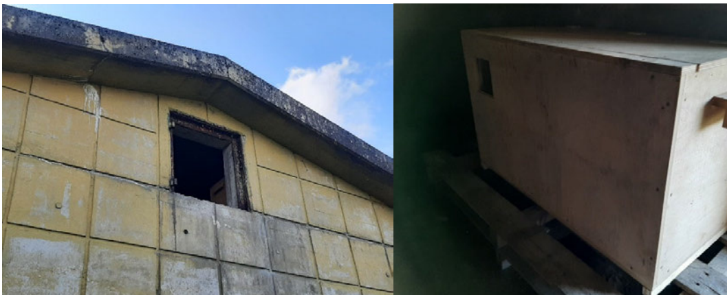
Figuur-2 Toegang tot de schuur met keruilkast en de geplaatste kast.
