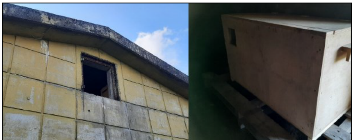
Figuur 4: De opening die toegang geeft tot de zolder van de schuur en de geplaatste kast.
