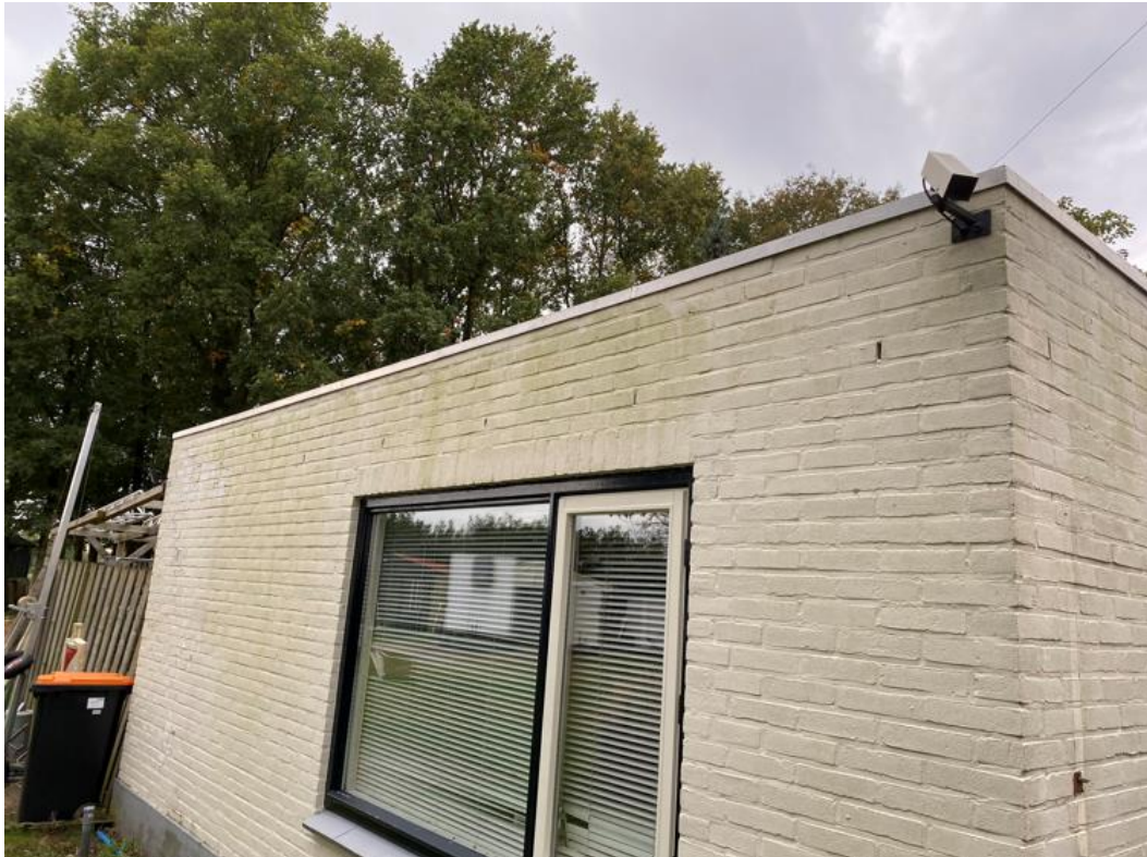
Overzicht open stootvoegen -16 - 07-11-2024 13:40
