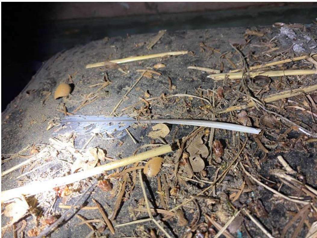
Gebouw B afgebeten veer -13 - 07-11-2024 13:40
