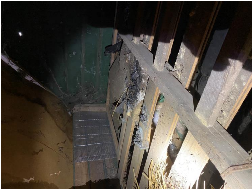
Gebouw B latrine marter -11 - 07-11-2024 13:39
