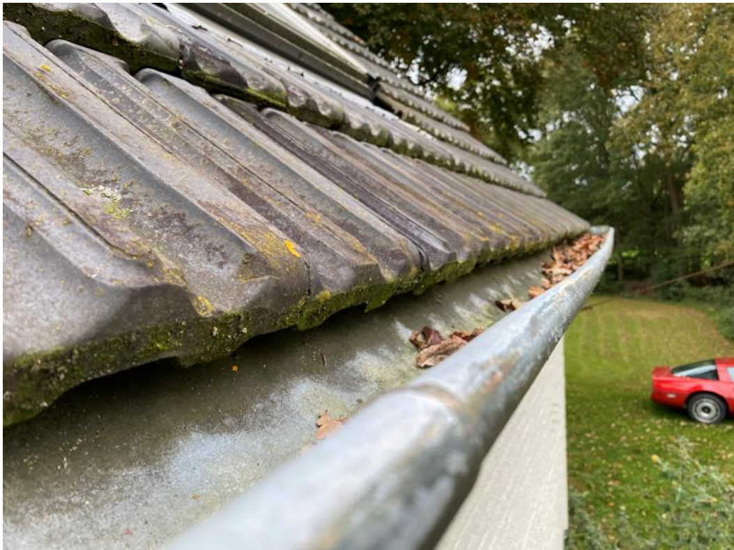
Gebouw A ruimte dakgoot en dakpannen -6 - 07-11-2024 13:39
