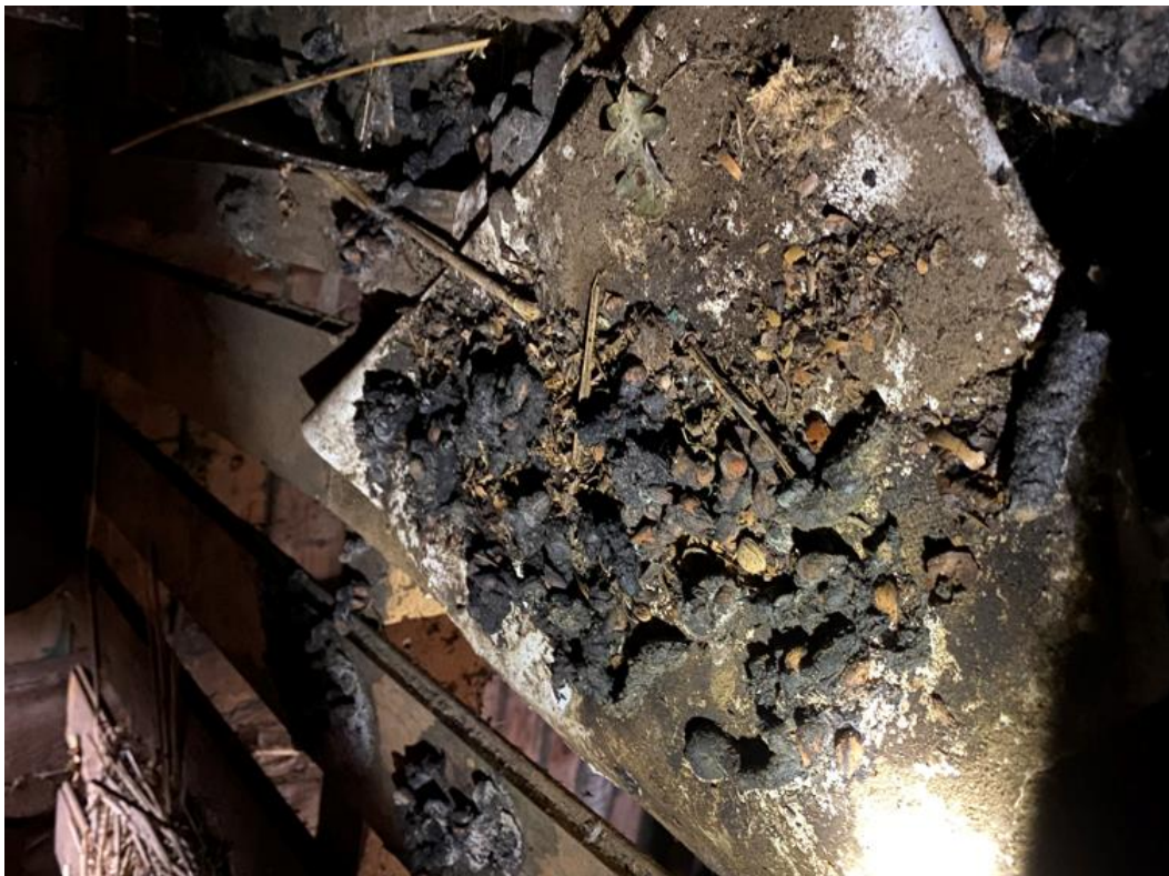
Gebouw B latrine naast stro -9 - 07-11-2024 13:39
