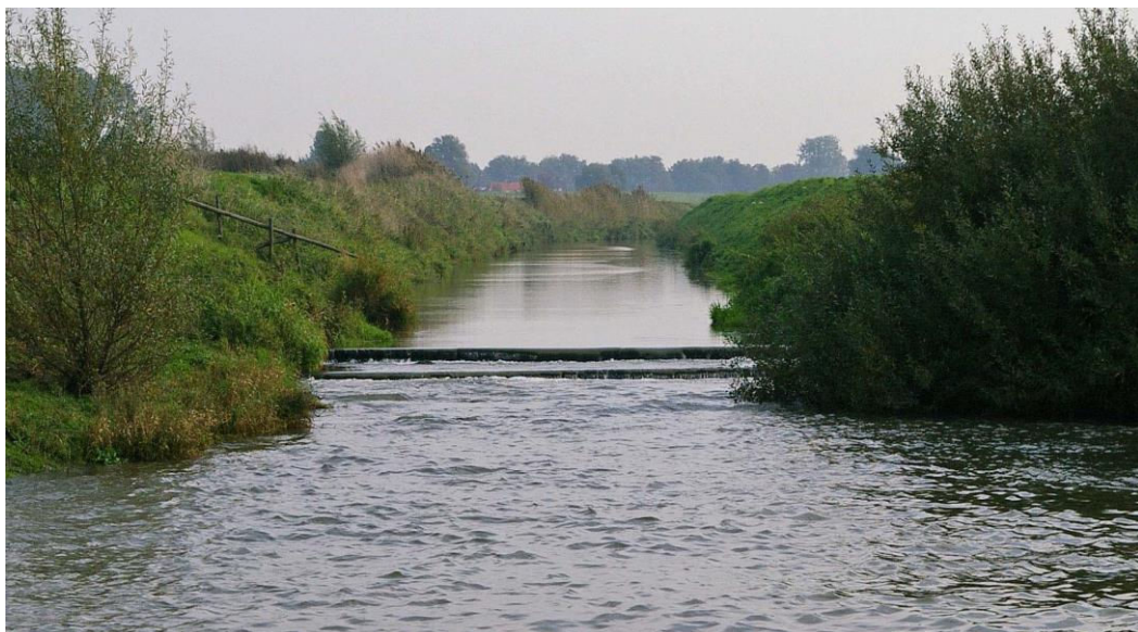
Figuur 6 Op te ruimen stuw in een beekmonding langs de Maas
