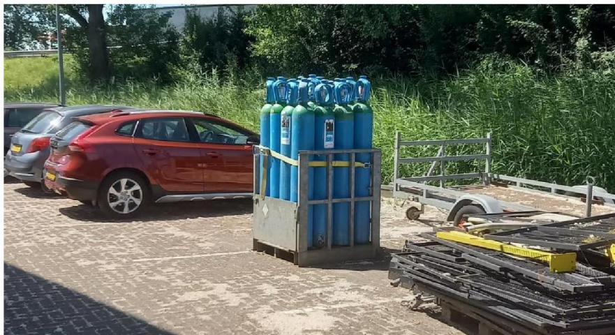
Figuur 9 Opslagvoorziening gasflessen
