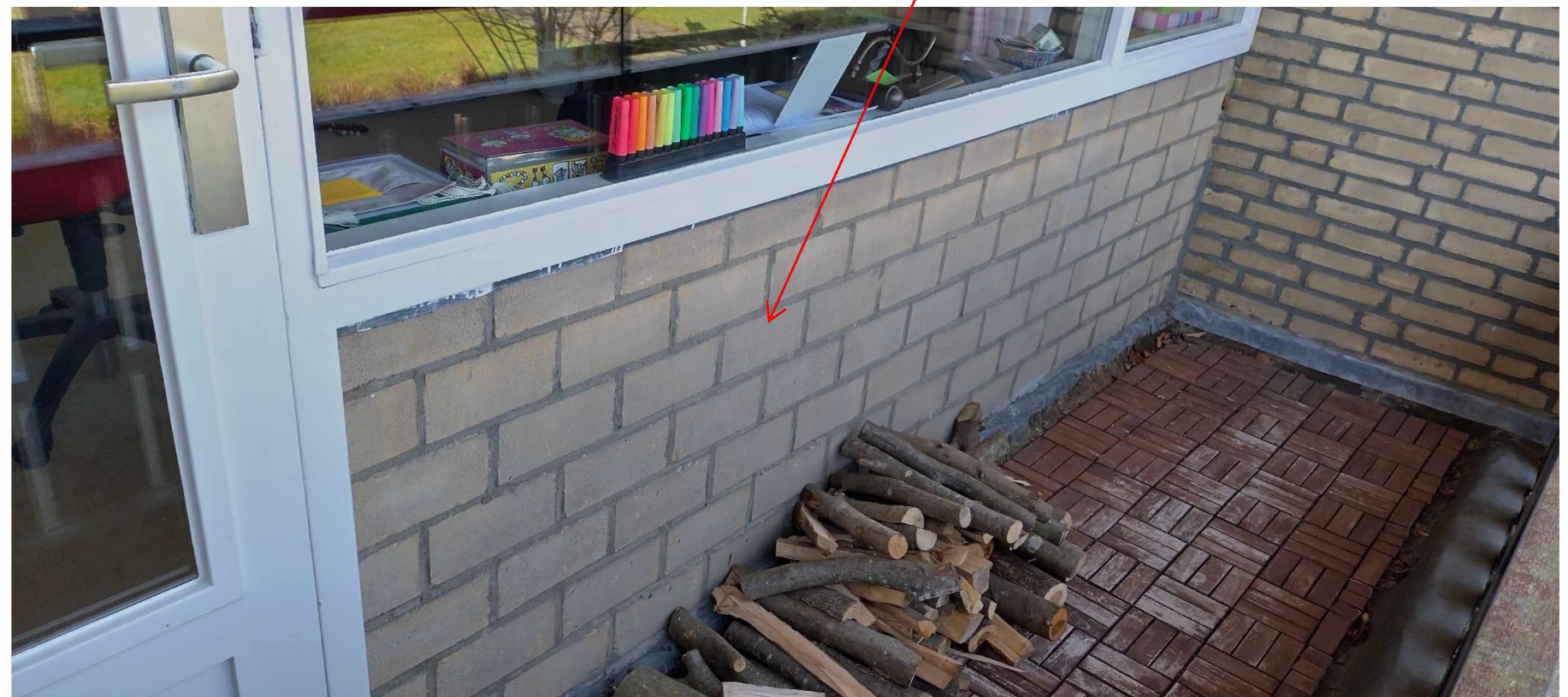
Buitenmuurtje Grote kamer voorzijde – Wordt vervagen door met isolatiemateriaal en afgedekt met plaat.
