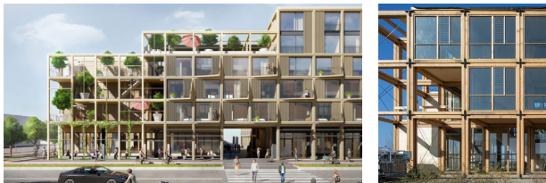
Transparantie, interactie binnen-buiten en gebruik van het dak
