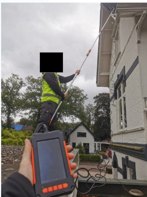
Figuur 11. Foto van de uitvoering van het onderzoek met de inspectiecamera.
