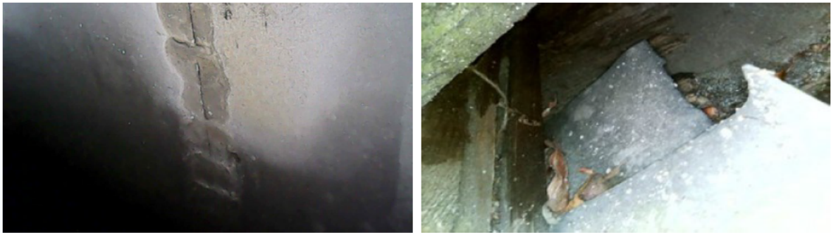
Figuur 3. Voorbeelden van de toegankelijke daklaag (links) en de loze ruimte onder de kantpannen (rechts) bij Stationsweg 6.
