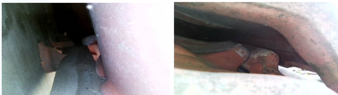
Figuur 8. Voorbeelden van de toegankelijke daklaag bij Paul Krugerstraat 14 (links) en 16 (rechts).
