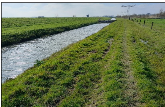
Figuur 4. Verhoogde strook (links) en onderhoudspad aan zuidkant plangebied.
