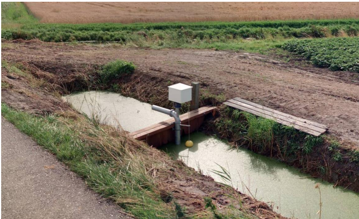
Figuur 2: foto van de onderbemalingspomp en houten damwand.
