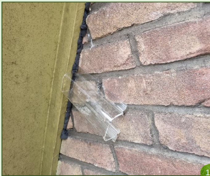
Figuur 1: Voorbeelden van vleermuiswerende voorzieningen op gevels.
