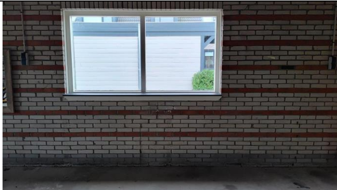
Raamkozijn in de zijgevel (zuidwestzijde)
