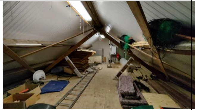
Zolderruimte onder de kap boven twee cellen
