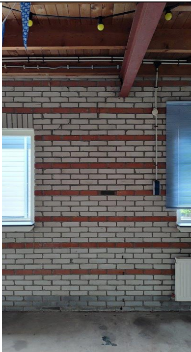
Binnenmuur van kalkzandsteen met speklagen
