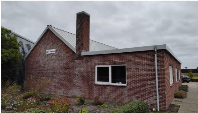
Voorgevel van de bollenschuur (noordwest zijde)
