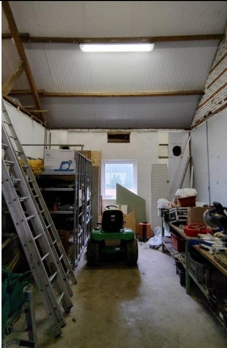
Interieur van de eerste cel, waarvan het plafond is verwijderd
