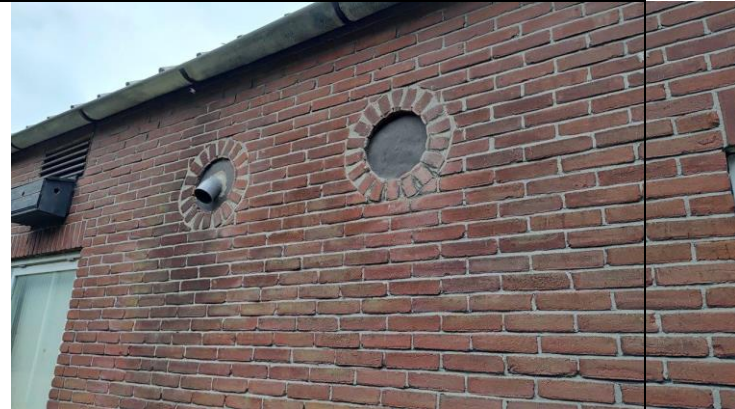
Dichtgemetselde ventilatieopeningen (2023)
