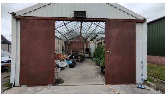
Achtergevel aangebouwde schuurkas
