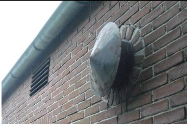
Oorspronkelijke zinken ventilatiekap (2013)
