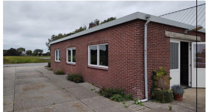
Zijgevel (zuidwest zijde)
