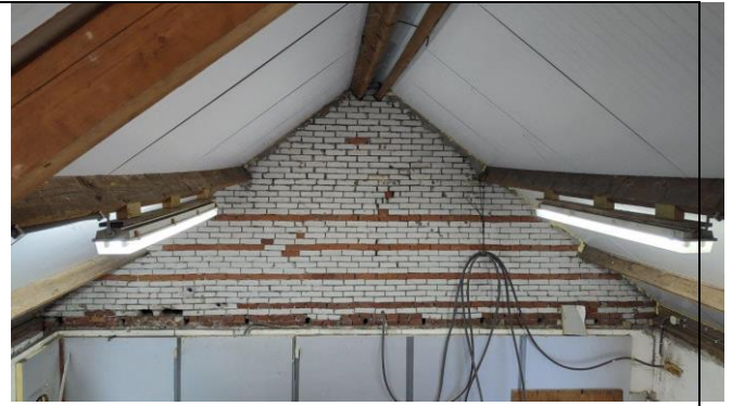
Achtergevel in de eerste cel, waarvan het plafond is verwijderd. Het metselwerk is grof uitgevoerd.
