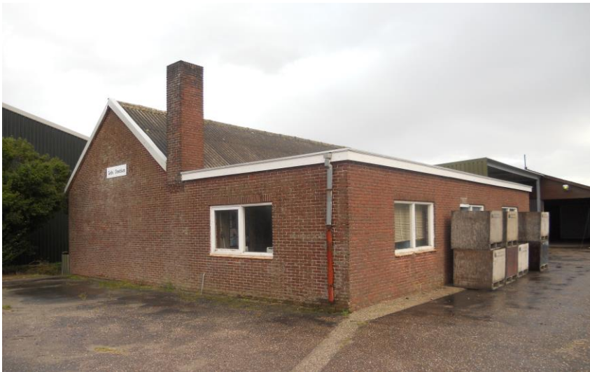
De bollenschuur in 2013, nog met eterniet golfplaten dak.
