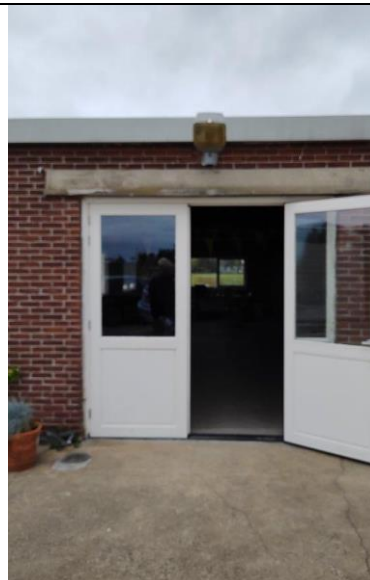
Deur in achtergevel (zuidoostzijde)
