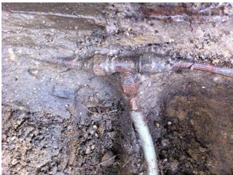
Foto splitsing brandstofleiding t.h.v. achtergevel woning
