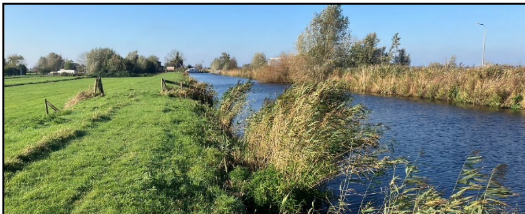
Afbeelding 2. Impressie plangebied zuidoever ten westen van A2. Op de achtergrond bevinden zich gemaal De Ruiter en de Demmerikse sluis.
