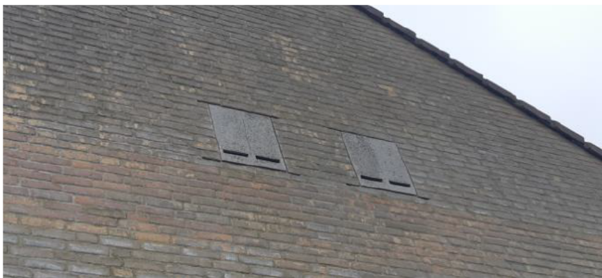
Figuur 7.3 Ingemetselde vleermuisverblijfplaatsen. Bron: Ecogroen.
