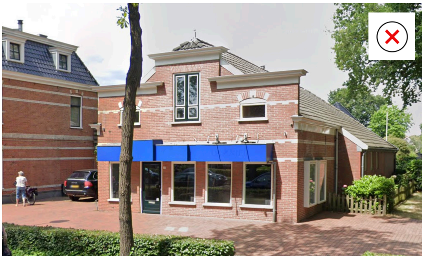
De permanente luifels passen in kleur en vorm niet binnen karakteristieke architectuur en verstoren de samenhang tussen de begane grond en de eerste verdieping.
