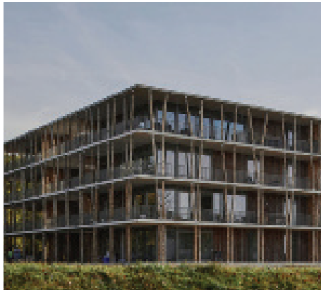
hout en glas -Bosbad Eindhoven, GAAGA Architecten-
