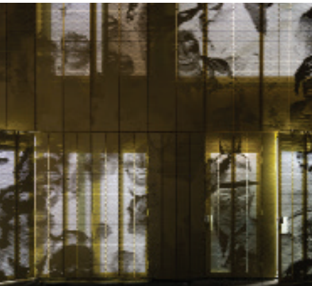
Afvalruimte en nuts geïntegreerd in de gevel -McDonald's Coolsingel, Mei Architects-
