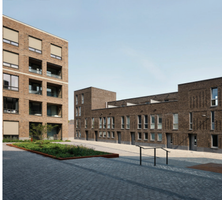
industriële en traditionele -Sphinxkwartier Maastricht, Dreessen Willemse Architecten-
