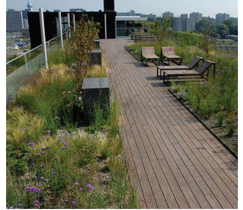
functioneel en ecologisch gebruik van daken -Dakpark De Boel, Dakdokters-
