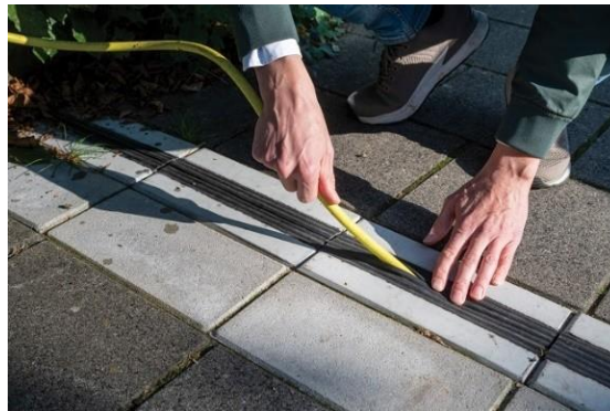
Figuur 4-1 Kabelgoot
