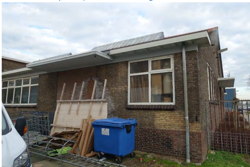
Afb. 162 De vensters in de zuidgevel hebben nieuwe invullingen. De rechter deuropening is dichtgemetseld.
