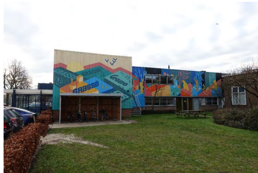
Afb. 201 Noordgevel van gebouw 7.
