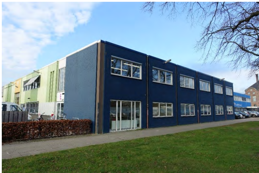
Afb. 199 Overzicht oostzijde van gebouw 14.
