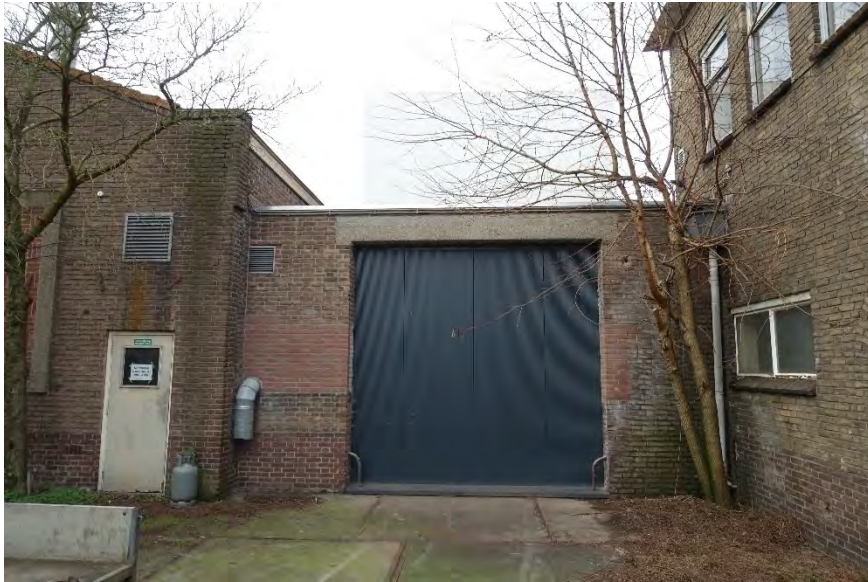
Afb. 174 Oostgevel van het verbindingslid.
