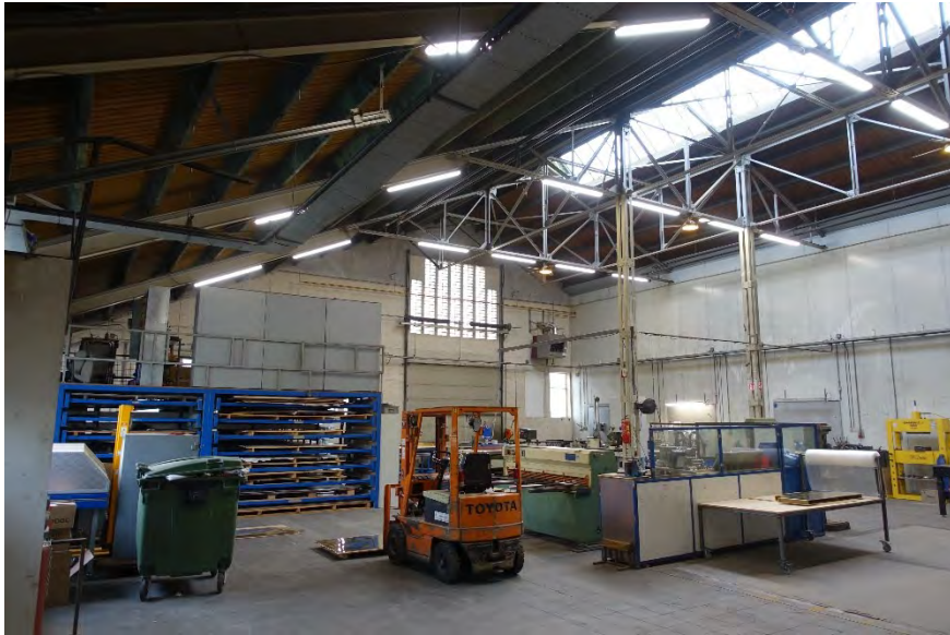
Afb. 169 Interieur oostelijke hal.
