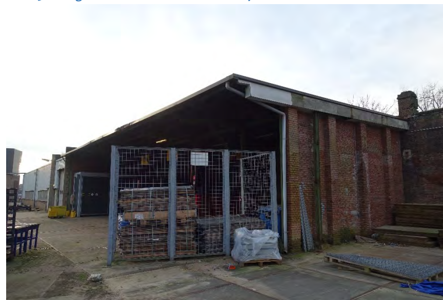
Afb. 139 Het middendeel van het oorspronkelijke afdak bleef bewaard.
