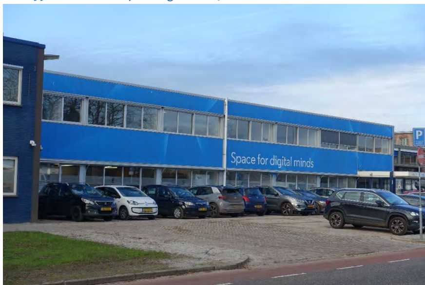
Afb. 200 Oostgevel van gebouw 7.
