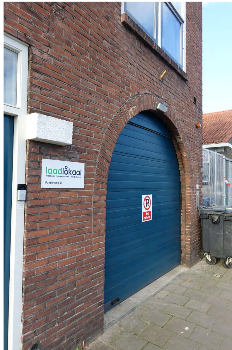
Afb. 210 Detail boogopening met vernieuwde deur.
