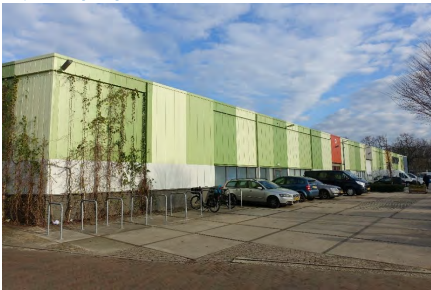
Afb. 204 Overzicht van de zuidgevel van gebouw 14.
