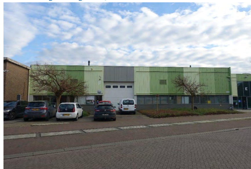
Afb. 202 Westgevel van gebouw 7.
