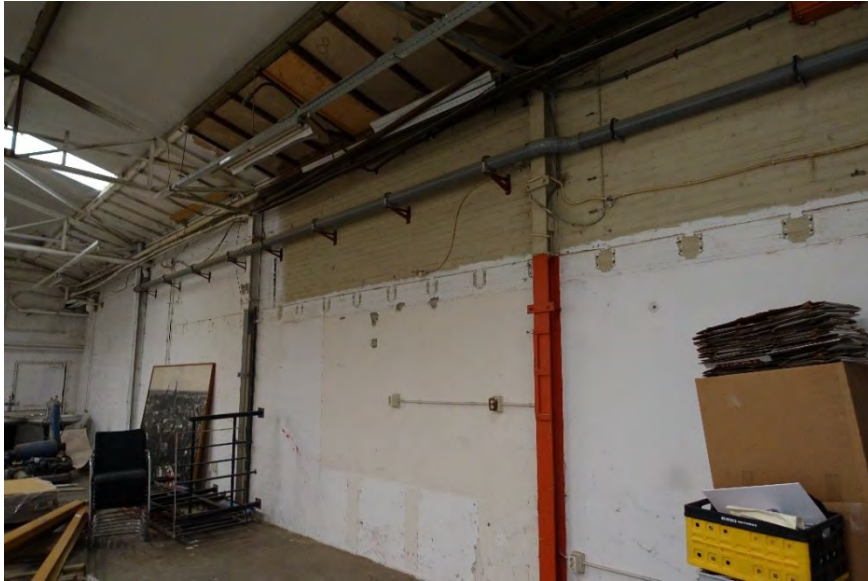
Afb. 193 De oorspronkelijke zuidgevel werd vervangen door een halfsteens muur.
