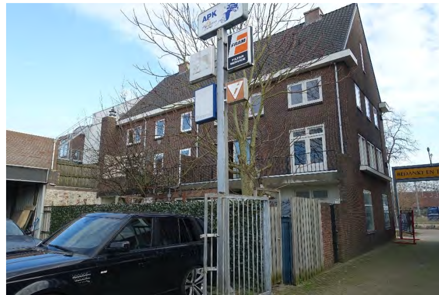
Afb. 219 Overzicht achtergevel vanaf het achterterrein.
