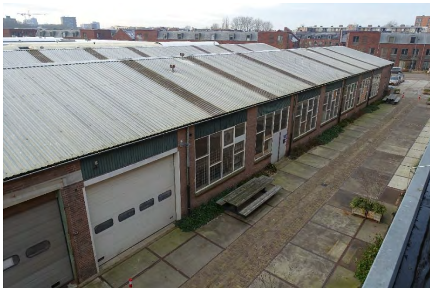
Afb. 185 Zicht over de bedrijfshal in westelijke richting.
