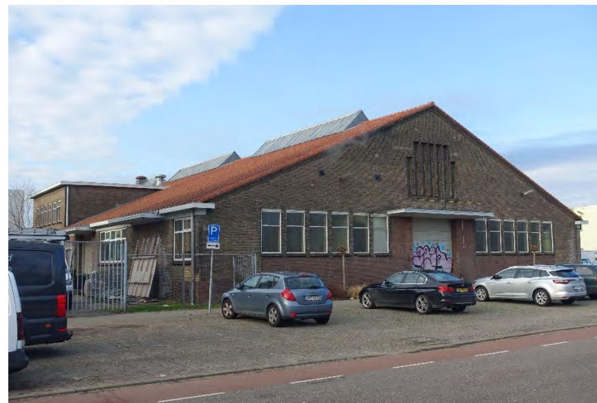
Afb. 160 Oostgevel van het voormalige veilinggebouw.
