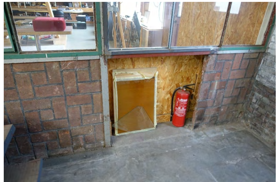
Afb. 172 Borstwering met siermetselwerk.
