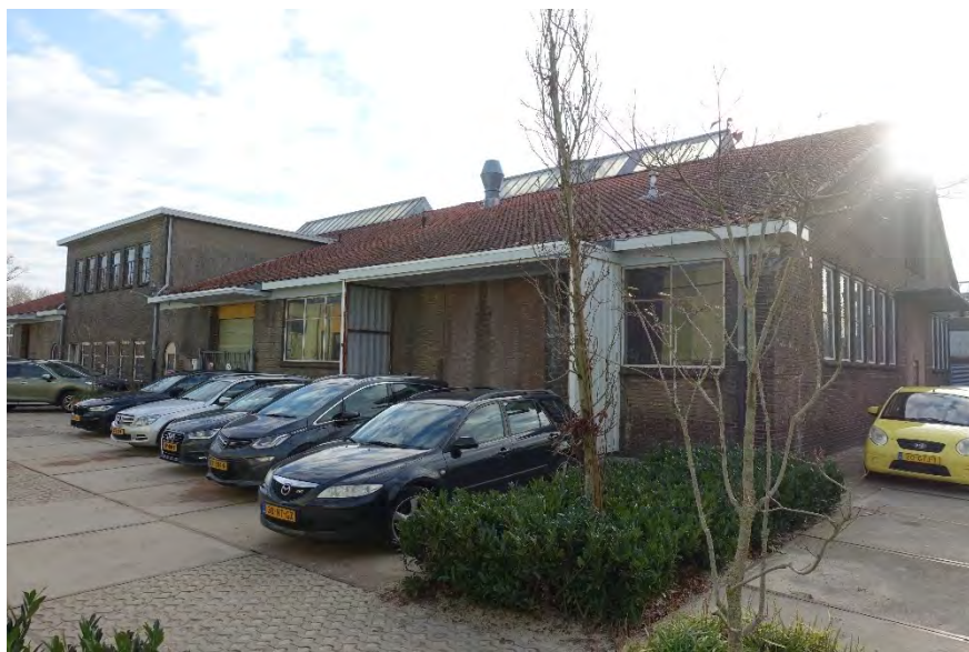
Afb. 166 Noordwesthoek, met ook hier een dichtgemetselde deuropening.
