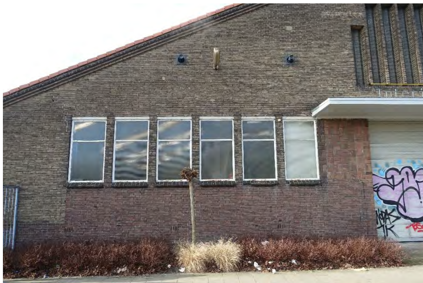
Afb. 161 Detail oorspronkelijke vensters in de oostgevel.
