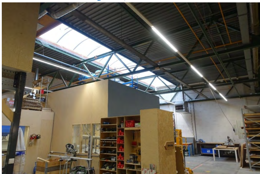
Afb. 207 Eén van de afgescheiden bedrijfsruimtes in gebouw 7.
