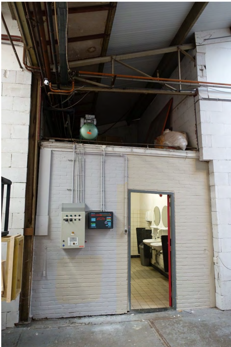
Afb. 191 Oorspronkelijke toiletgroep tegen de (vroegere) zuidgevel.
