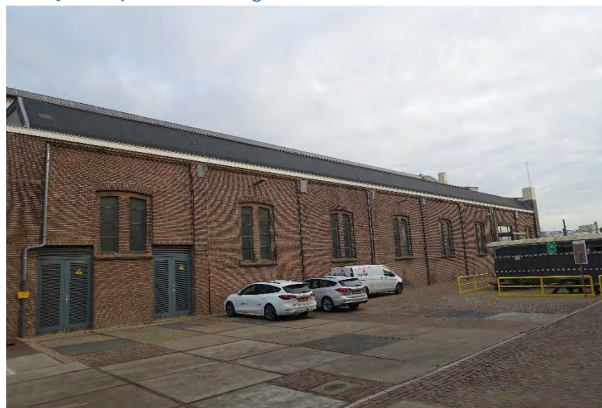
Afb. 120 Oostelijk deel van de zuidgevel.
