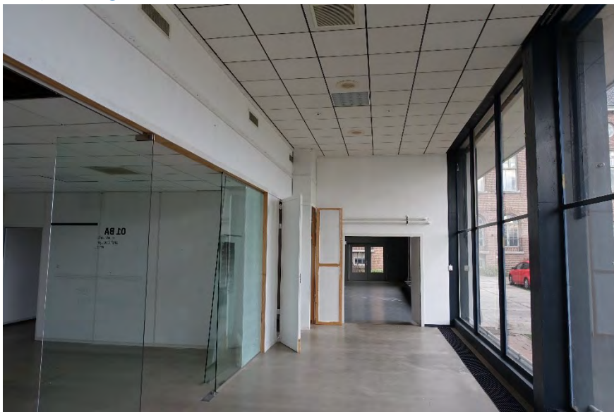
Afb. 182 Zicht langs de oostgevel van de showroom in noordelijke richting.
