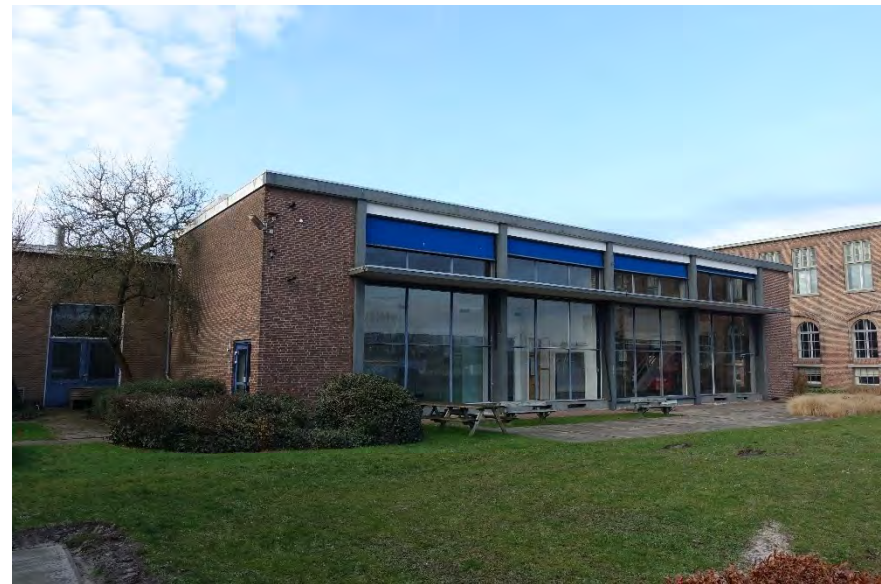
Afb. 180 De voorgevel, gezien over het bijbehorende gazon.
