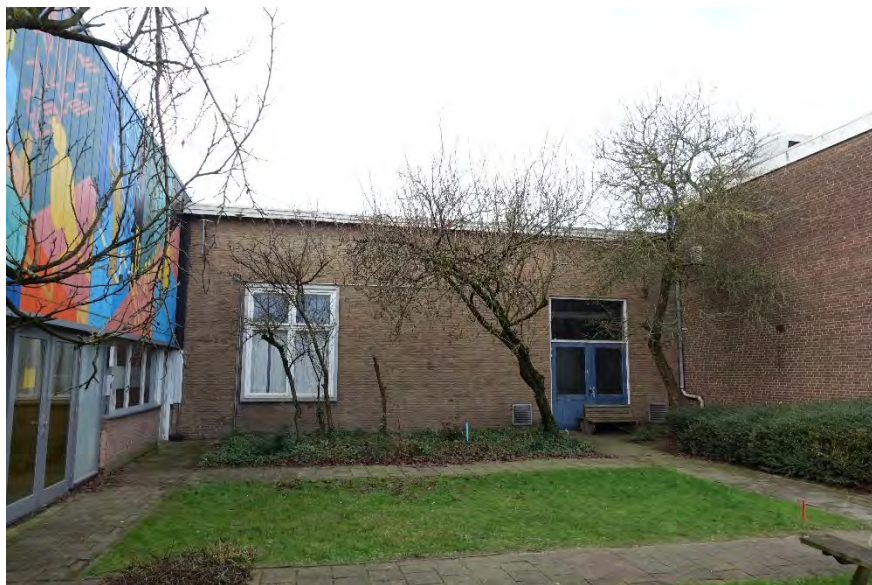
Afb. 194 Oostgevel van de bedrijfshal.
