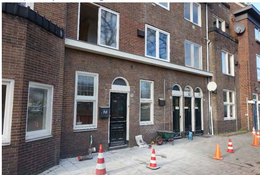
Afb. 216 Onderzijde van de voorgevel, met op de begane grond nog deels de oorspronkelijke invullingen van gevelopeningen.
