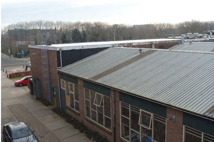
Afb. 181 Aan de achterzijde is goed zichtbaar dat de showroom als een voorbouw voor de bedrijfshal fungeert.
