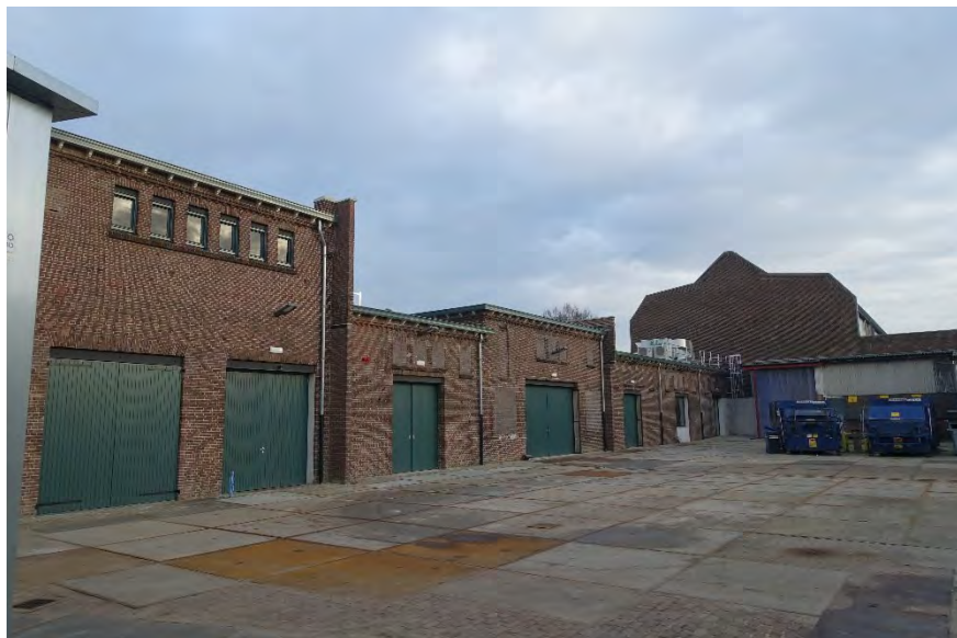
Afb. 121 Overzicht zuidgevel van de achtervleugel.
