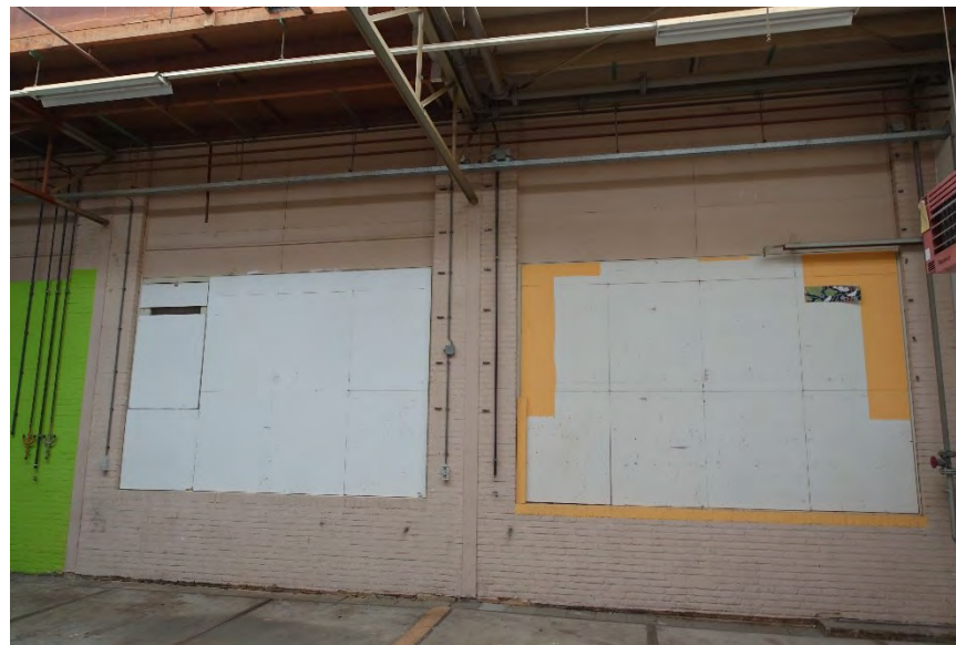
Afb. 198 De vermoedelijk vanuit hal 5 overgeplaatste oorspronkelijke puin van de zuidgevel zijn nog aanwezig, maar werden afgeplaat.
