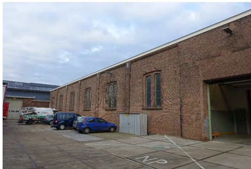
Afb. 119 Westelijk deel van de zuidgevel.
