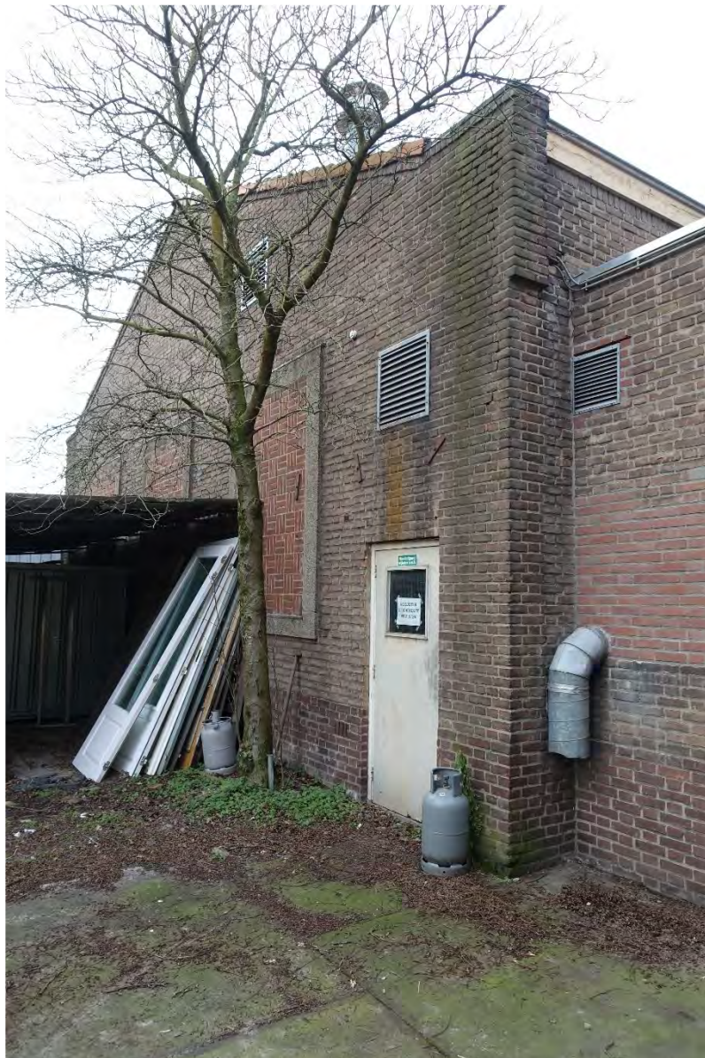
Afb. 175 Oostgevel van de hal met drie vlakken siermetselwerk in plaats van vensters.
