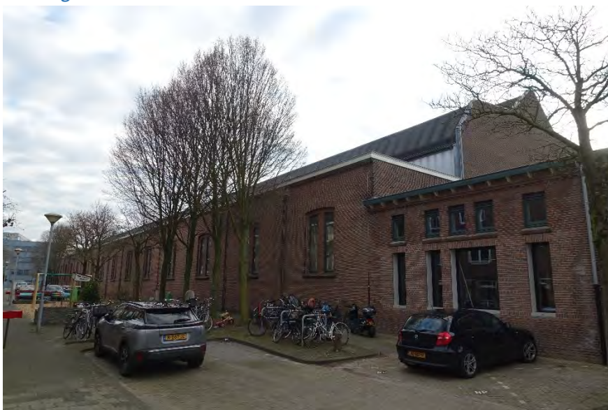
Afb. 118 Noordwesthoek van het hoofdvolume met aansluitende achtervleugel (rechts).
