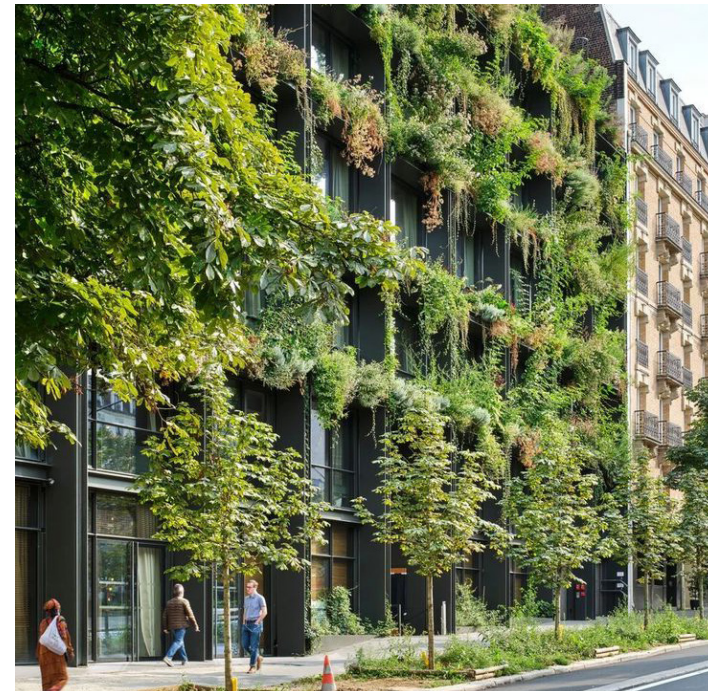
Groene gevels langs spoorzijde
