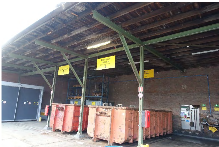
Afb. 140 Beeld van de oorspronkelijke constructie van het afdak.
