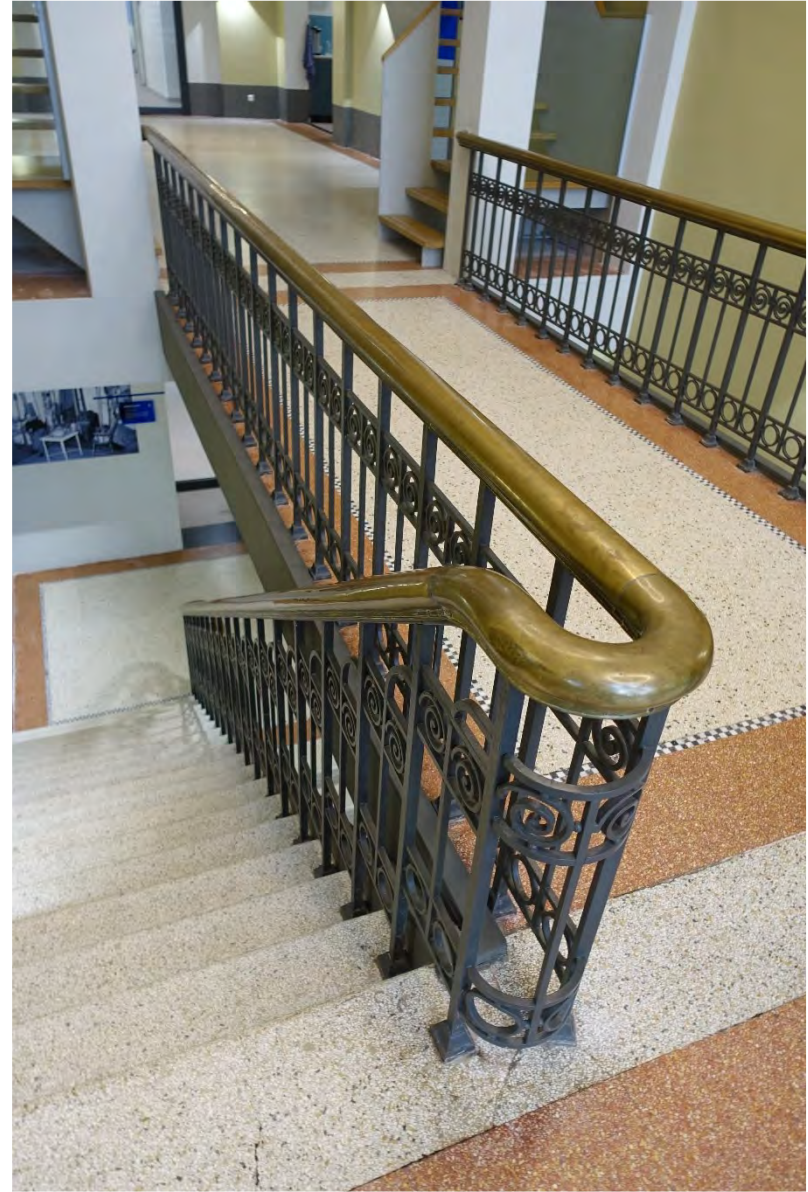
Afb. 155 Detail van de smeedijzeren balustrades in het trappenhuis.
