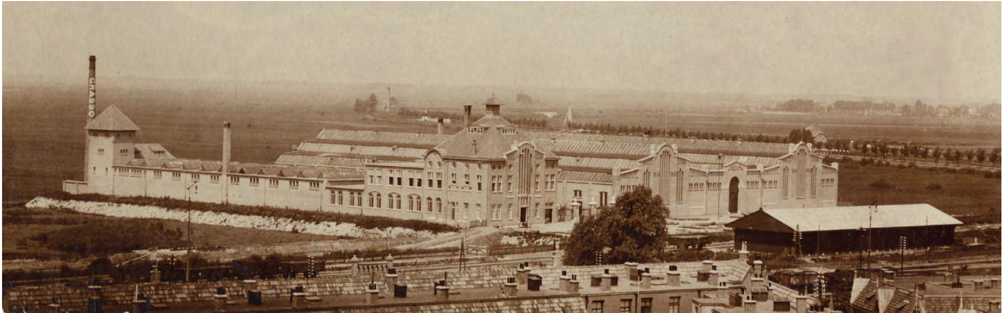
Afb. 37 Mooi beeld van de Grasso-fabriek in 1914, gezien vanaf de Sint-Leonarduskerk. Links van het kantoor is de rand van de terreinverhoging goed herkenbaar. BAAC 2014, p. 16.
