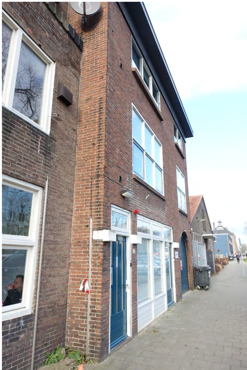
Afb. 209 Overzicht voorgevel van het pand.
