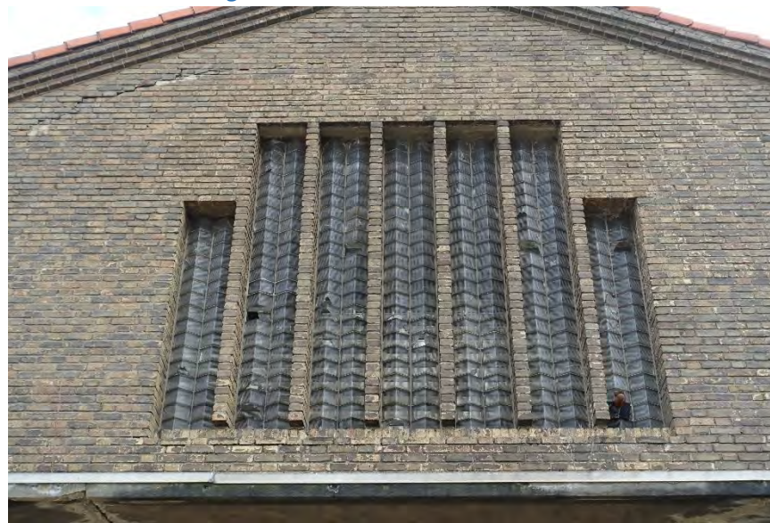
Afb. 168 Detail fraai venster met prismavormige glazen bouwstenen.
