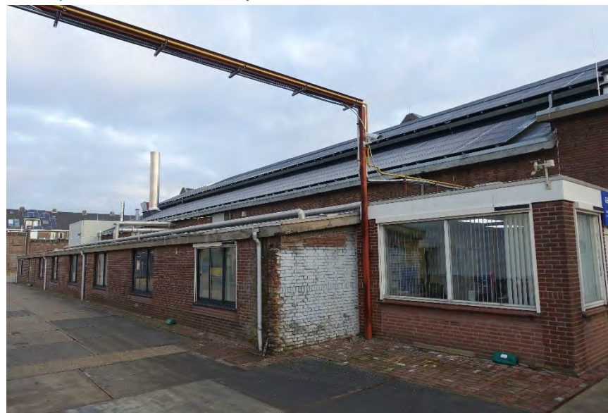
Afb. 130 Het oorspronkelijke betonnen afdak is dichtgemaakt en tegen de zuidgevel is een aanbouw gebouwd.
