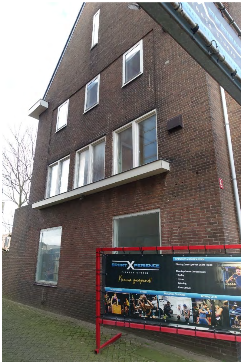
Afb. 218 Overzicht van de linkerzijgevel. Rechts bevond zich oorspronkelijk de toegang tot de linker benedenwoning.
