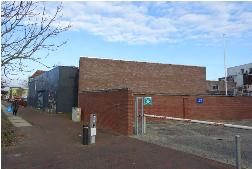
Afb. 223 Overzicht zuidzijde van het gebouw.
