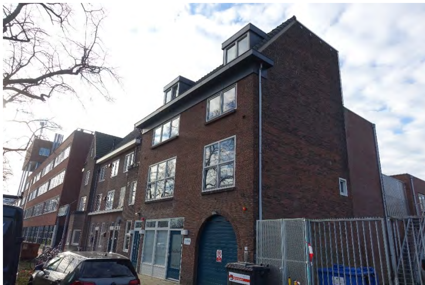
Afb. 211 Overzicht vierlaags voorbouw.
