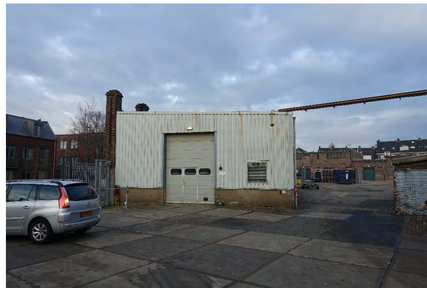
Afb. 138 Zuidgevel van het vernieuwde zuidelijke deel van bouwdeel 12.
