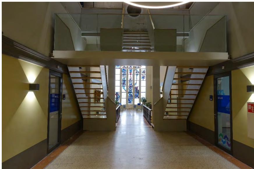
Afb. 156 De oorspronkelijke trappen werden bij de herbestemming aangevuld met een eigentijdse bordestrap.
