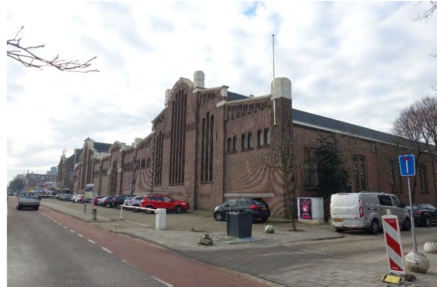
Afb. 115 Overzicht van de voorgevel uit het noordoosten.
