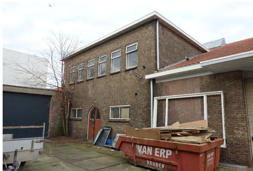
Afb. 163 Tweelaags middendeel van de zuidgevel.
