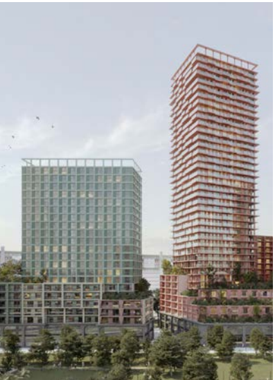
Hoogbouw als ensemble
