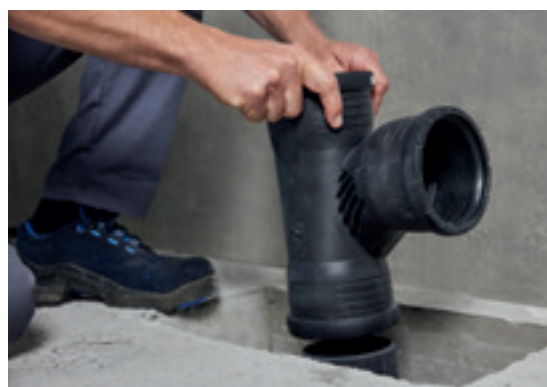
Een afvoersysteem met Geberit Silent-Pro SuperTube wordt in elkaar gezet.
