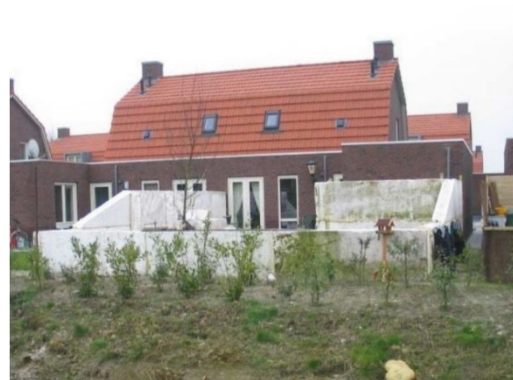
Voorbeelden elders van ondeugdelijk/laagwaardig materiaalgebruik bij aanbouw (van plaatmateriaal dat niet voor buitentoepassing is bedoeld), resp. erfafscheiding (van bouwblokken voor binnenwanden)
