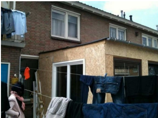
Voorbeelden elders van ondeugdelijk/laagwaardig materiaalgebruik bij aanbouw (van plaatmateriaal dat niet voor buitentoepassing is bedoeld), resp. erfafscheiding (van bouwblokken voor binnenwanden)
