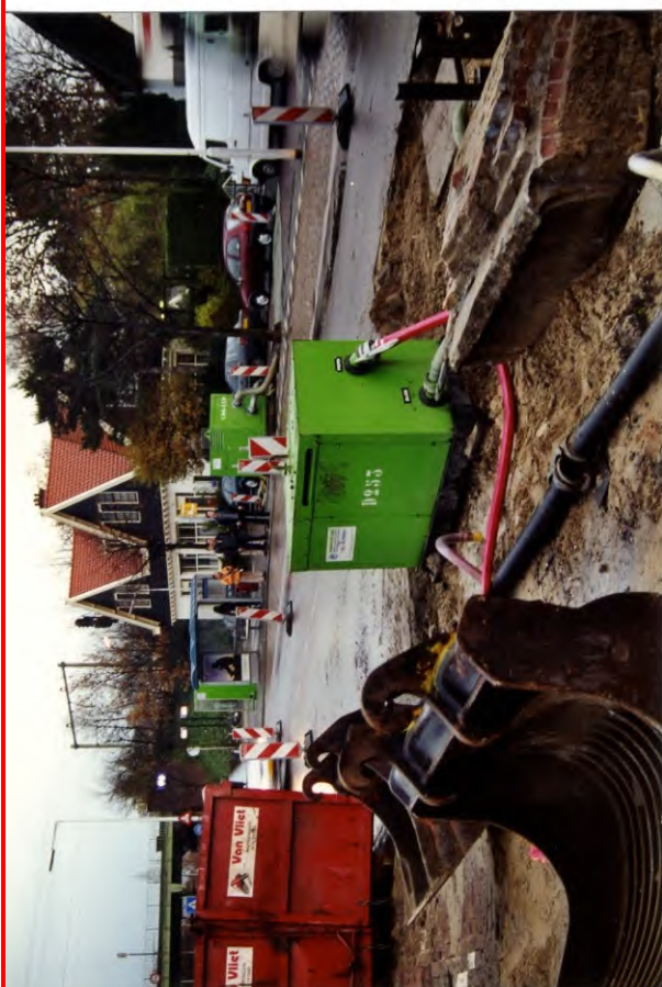
Oosteinde 241-243 (nov 2000) bronnering met zuivering
