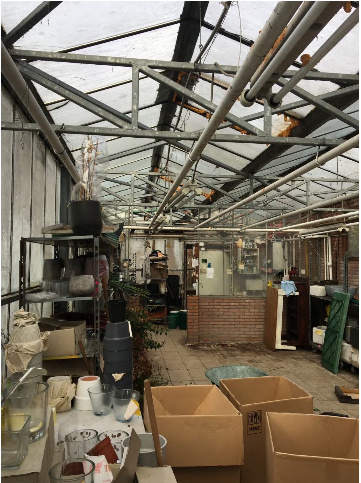
Foto d.d. 2017 van de kas aan het Oosteinde 245b
