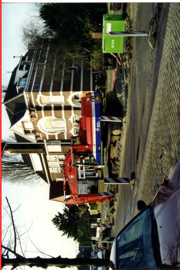
Oosteinde 241-243 (nov 2000) bronnering met zuivering
