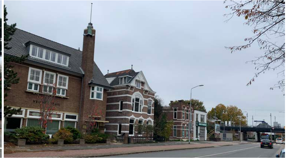
De kavelgewijze bebouwing aan het Oosteinde
