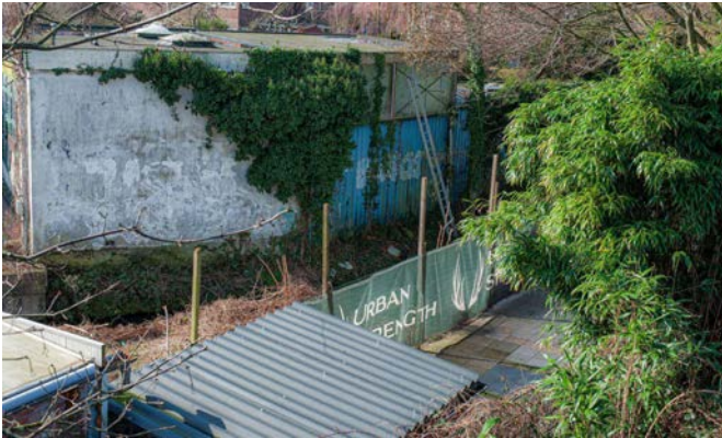
foto huidige situatie, gezien vanaf RandstadRail-halte
