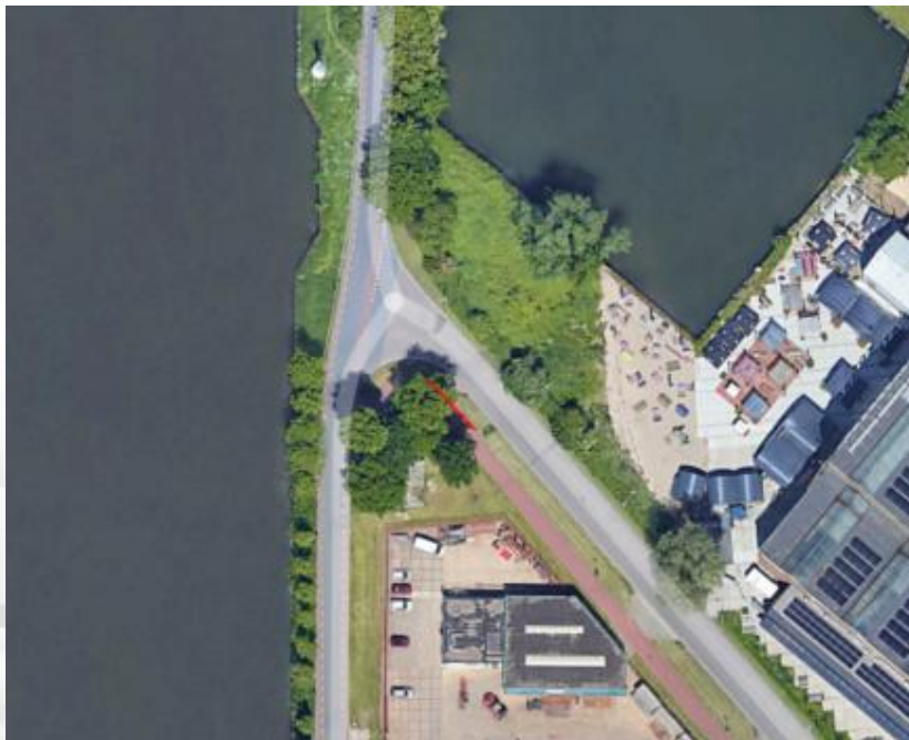
Figuur 1 overzicht werklocatie (Bron: Google Earth)
