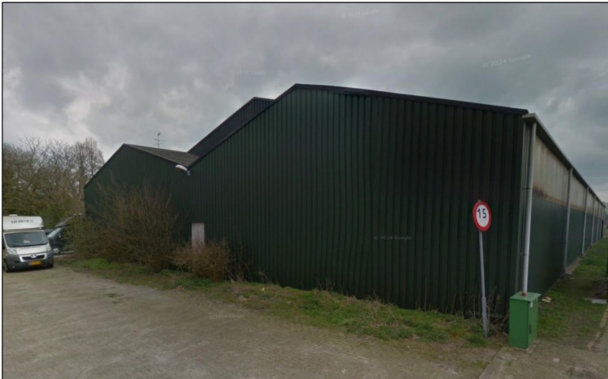
Figuur 7: Straatbeeld vanuit de Parallelweg met zicht op de paardenstal (manege)
