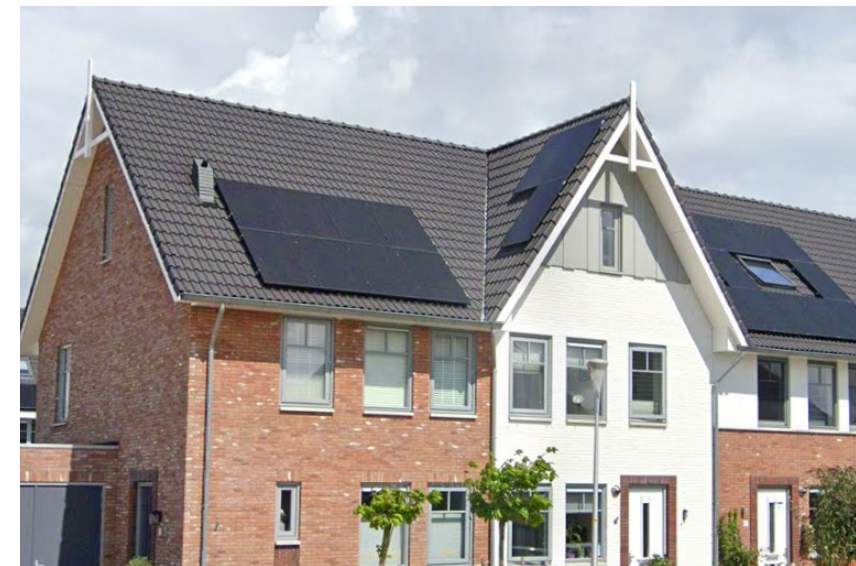
Figuur 50: Voorbeeld van Westfriese bouwstijl met zonnepanelen
