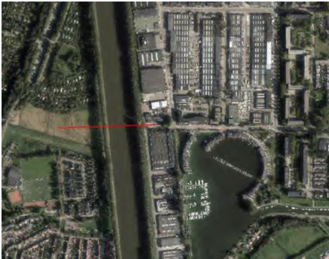
Figuur 1 Overzicht werklocatie
