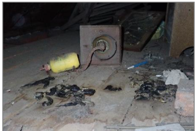
Afbeelding 3.6 | Latrine op de zolder van het woonhuis
