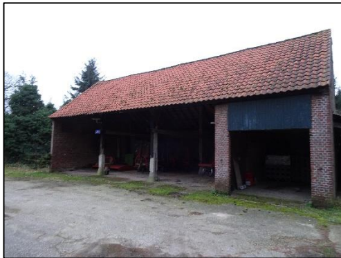
Aanzicht aanwezige open schuur;
