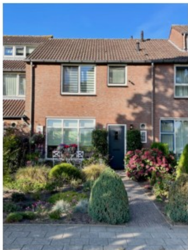
Foto bestaande situatie
